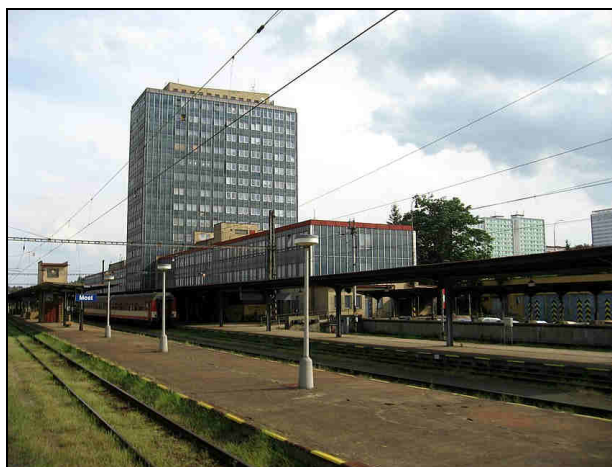
Obrázek 26 - Železniční nádraží Most – administrativní budova, několikapatrový objekt v bezprostřední blízkosti železniční trati, vystavený hluku překračujícímu mezní hodnoty v rámci hotspotu Most
