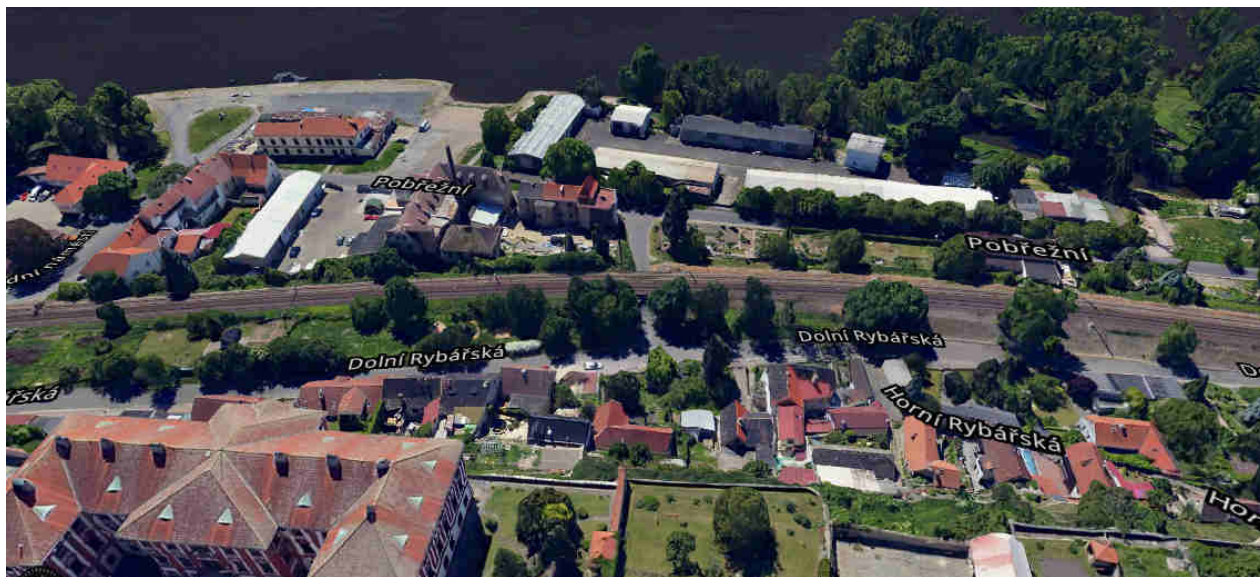
Obrázek 29 – úsek s objekty zasaženými hlukem překračujícím mezní hodnoty v ulicích Dolní Rybářská a Pobřežní
