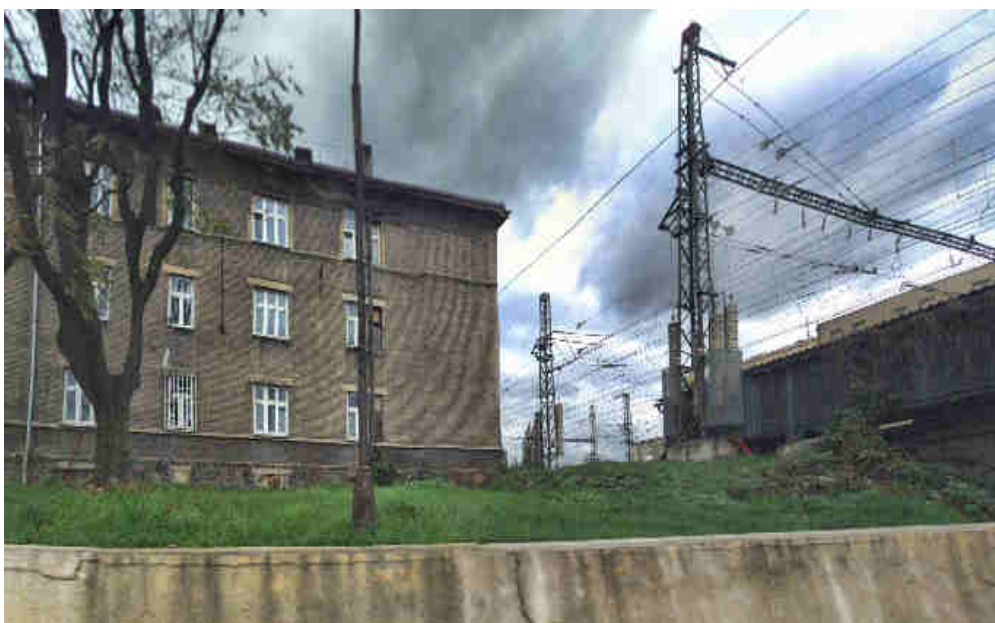
Obrázek 32 - Přerov, Kojetínská ulice – Objekt zasažený hlukem překračujícím mezní hodnoty
