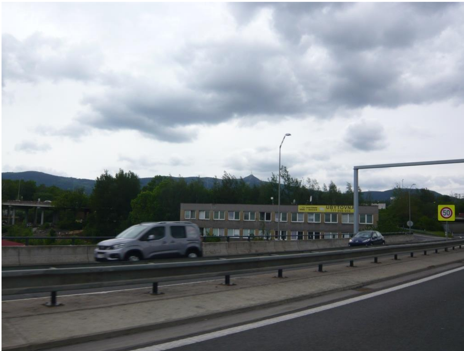
Obr. 10: Fotodokumentace víceúčelové stavby (ubytovny) v místě kritického místa priority I v Liberci
