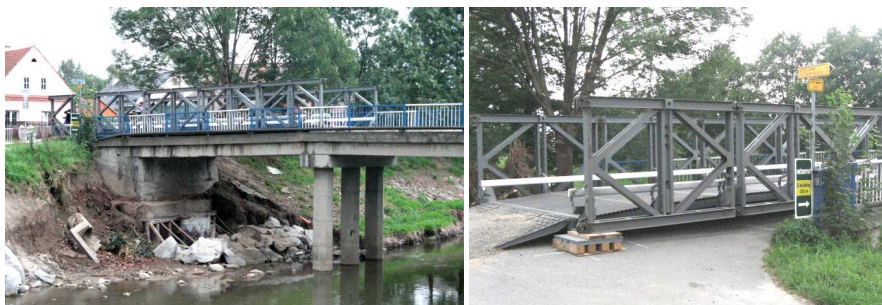
Obr. č. 3.5 Most ze soupravy MS nad původní mostní konstrukcí a detail uložení na břehu
