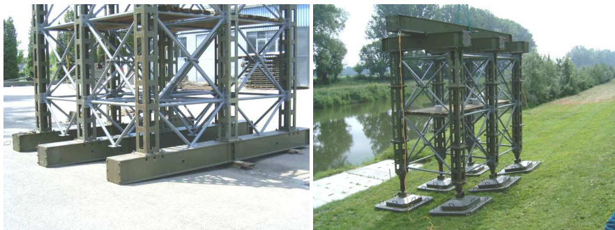
Obr. č. 5.20 Možné způsoby založení pilíře PIŽMO
