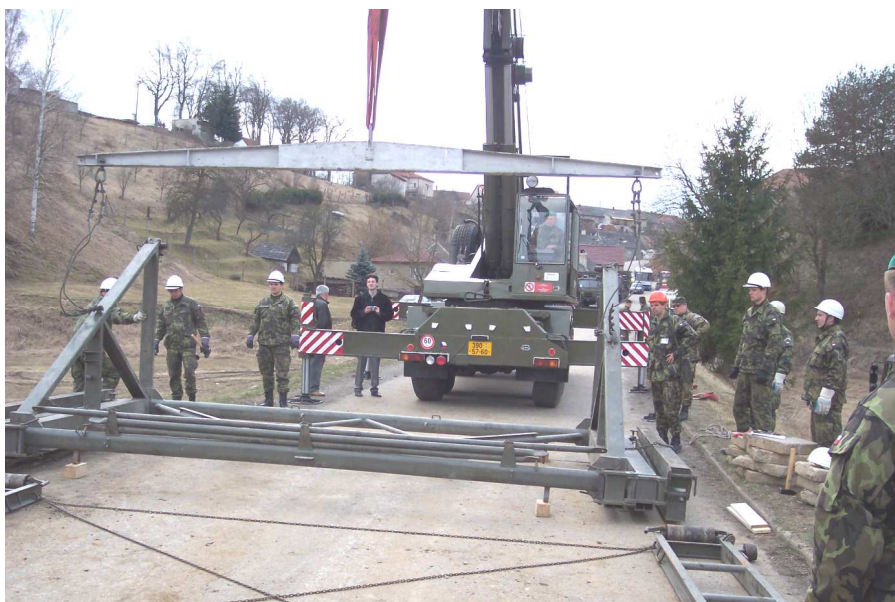
Obr. č. 5.10 Montáž krakorce na výsuvné dráze
