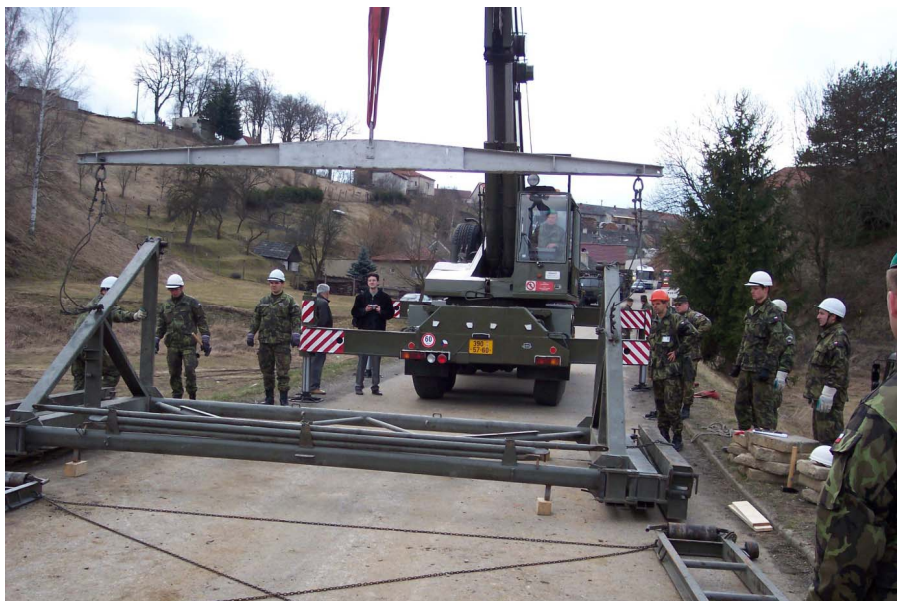
Umístění krakorce před výsuvnou dráhu
