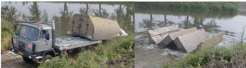
Obr. č. 2.7a Pontonová mostní souprava - technologie stavby
