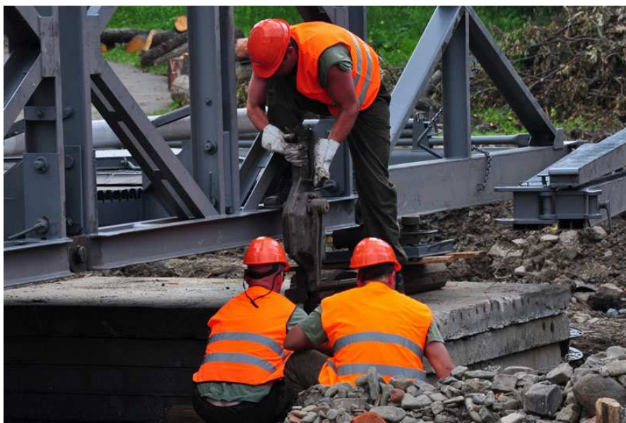
Obr. č. 5.16 Použití hřebenových zvedáků k přizvednutí mostu
