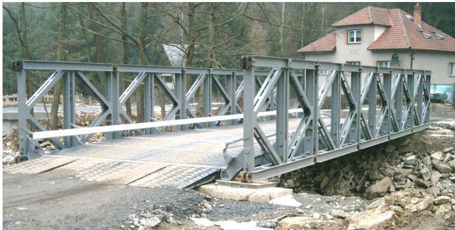
Obr. č. 4.10 Typické uložení mostní konstrukce na narušeném břehu
