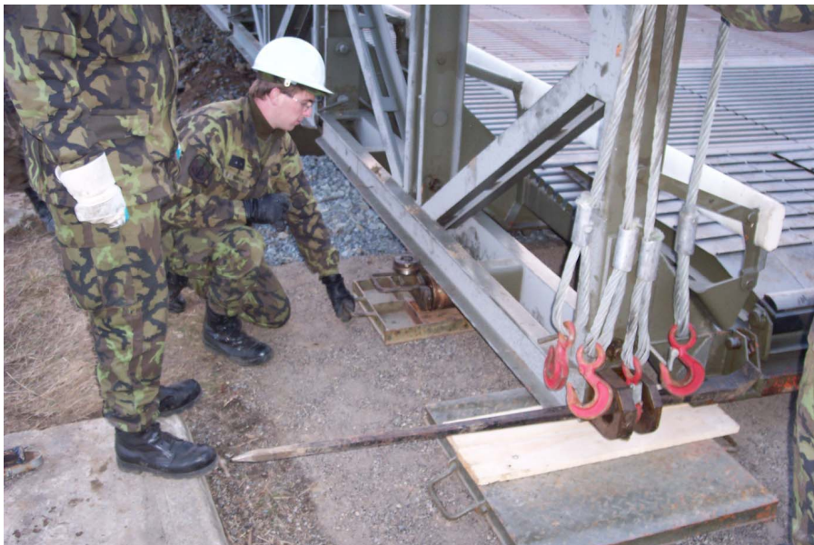
Uložení mostu na podkladové desky, zvednutí jeřábem
