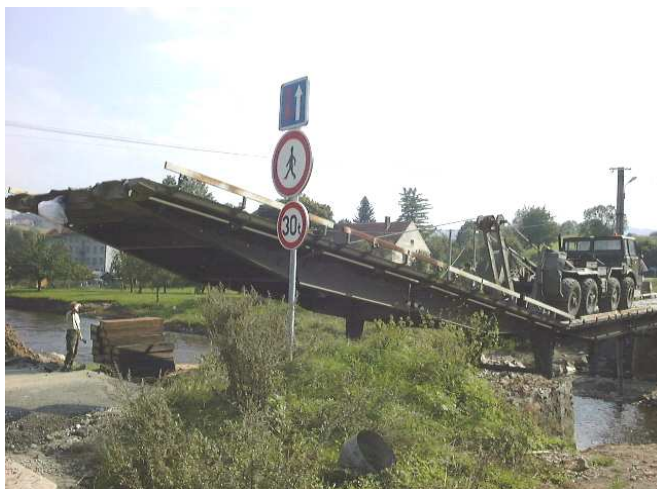
Obr. č. 2.4 Stavba mostu AM-50
