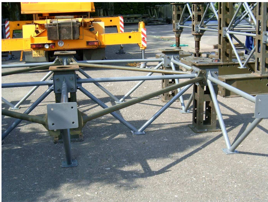
Obr. č. 5.22 Předmontovaný blok na zemi
