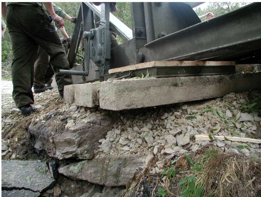
Uložení mostu na podkladové desky, zvednutí hřebenovým zvedákem
