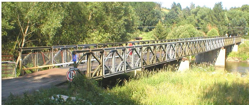
Obr. č. 3.3 Typický vícepolový most ze soupravy MS – každé pole působí jako prostý nosník
