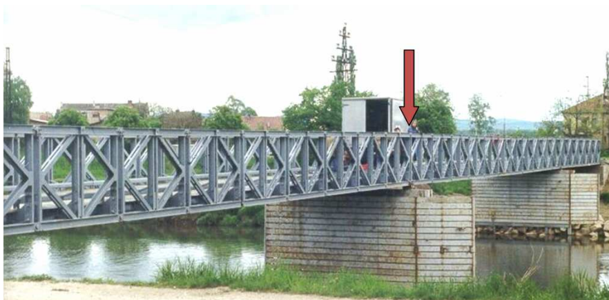
Obr. č. 3.4 Vícepolový most ze soupravy MS s označením vnitřního kloubu
