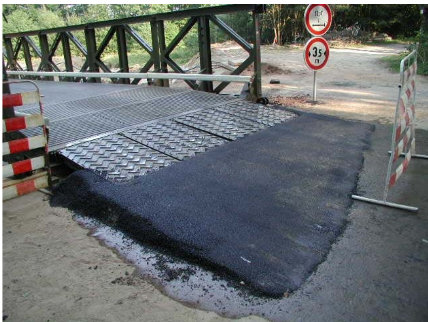
Vybudování nájezdů na most
