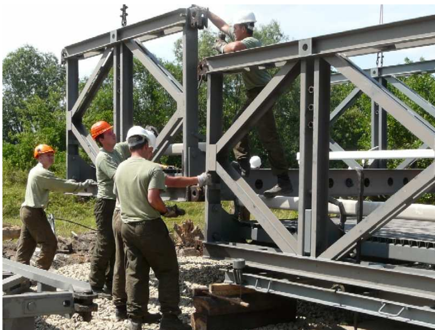
Obr. č. 5.13 Připojení dalšího mostního dílu
