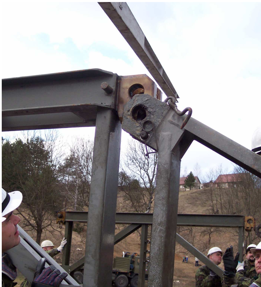
Obr. č. 5.11 Připojování koncového mostního dílu ke krakorci
