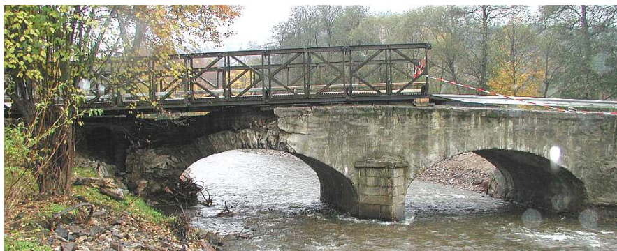
Obr. č. 4.12 Uložení mostní konstrukce na narušeném klenbovém mostu
