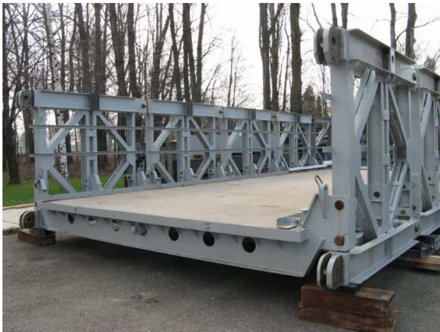
Obr. č. 2.9 Modernizovaná mostová souprava MMS
