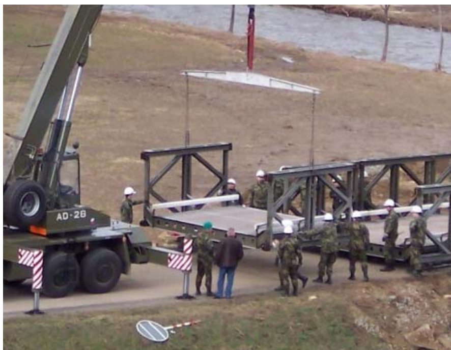
Připojení středního mostního dílu
