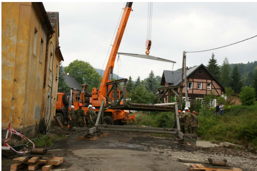
Připojení koncového mostního dílu ke krakorci
