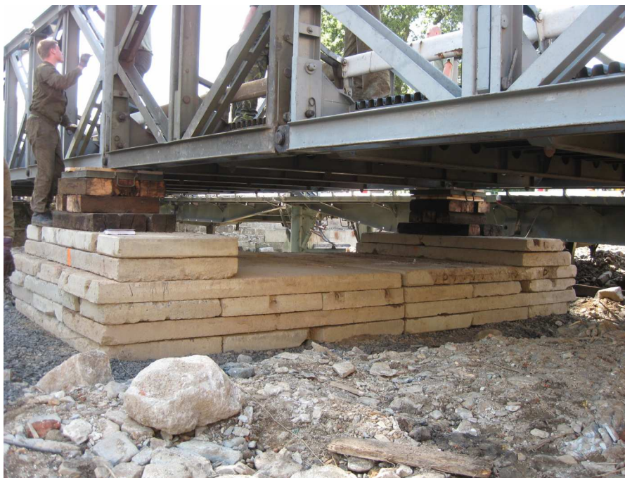
Obr. č. 3.6 Dočasná vnitřní podpora ze silničních panelů
