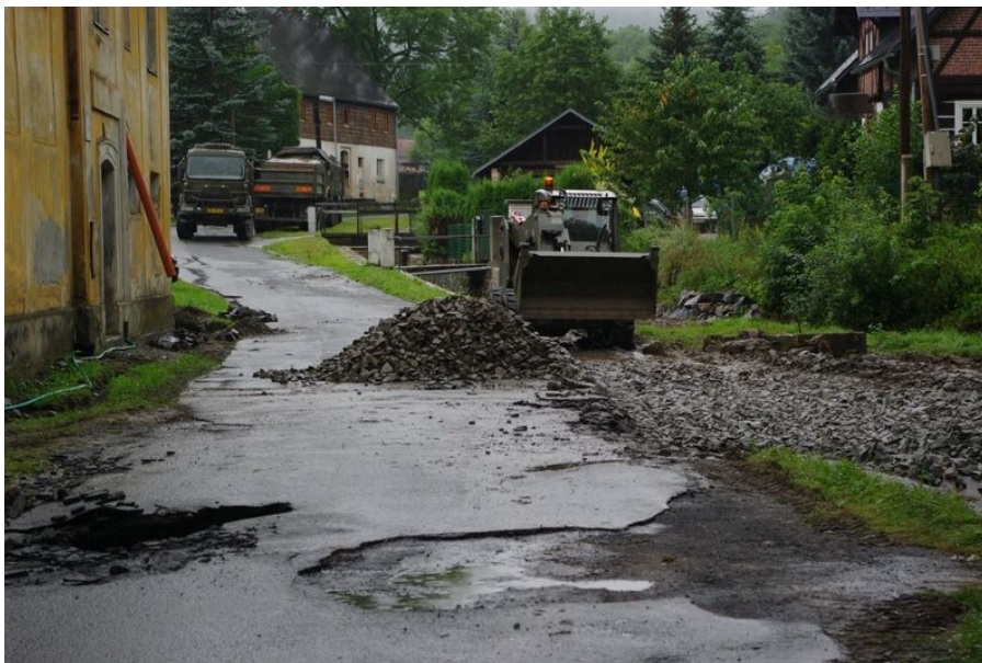
Terénní úpravy před stavbou
