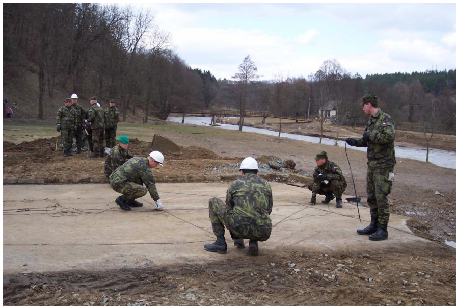
Obr. č. 5.7 Použití vytyčovacího lanka pro vytyčení mostní osy a os výsuvných kolejí
