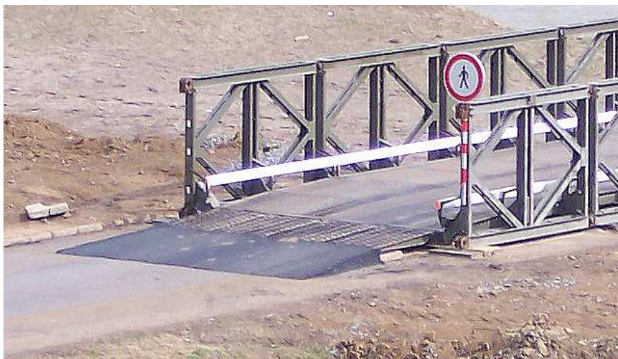
Obr. č. 4.11 Typické uložení mostu na původní nenarušené komunikaci
