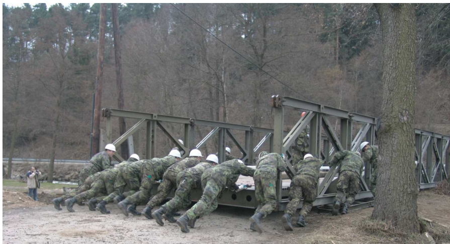
Obr. č. 5.14 Vysouvání mostu pomocí lidské síly
