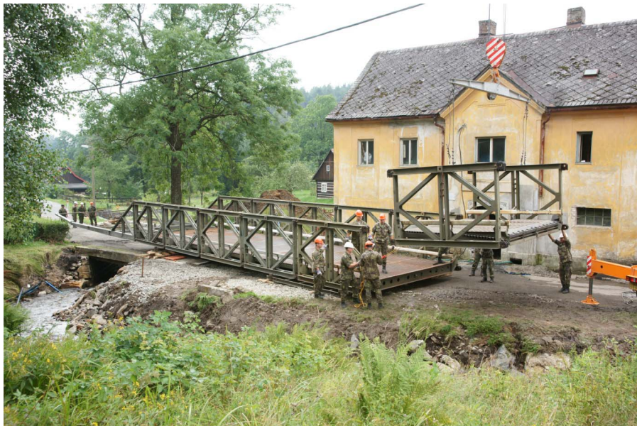
Připojení koncového mostního dílu
