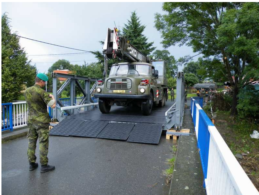
Obr. č. 5.18 Zatěžovací zkouška na mostě MS v Kuníně
