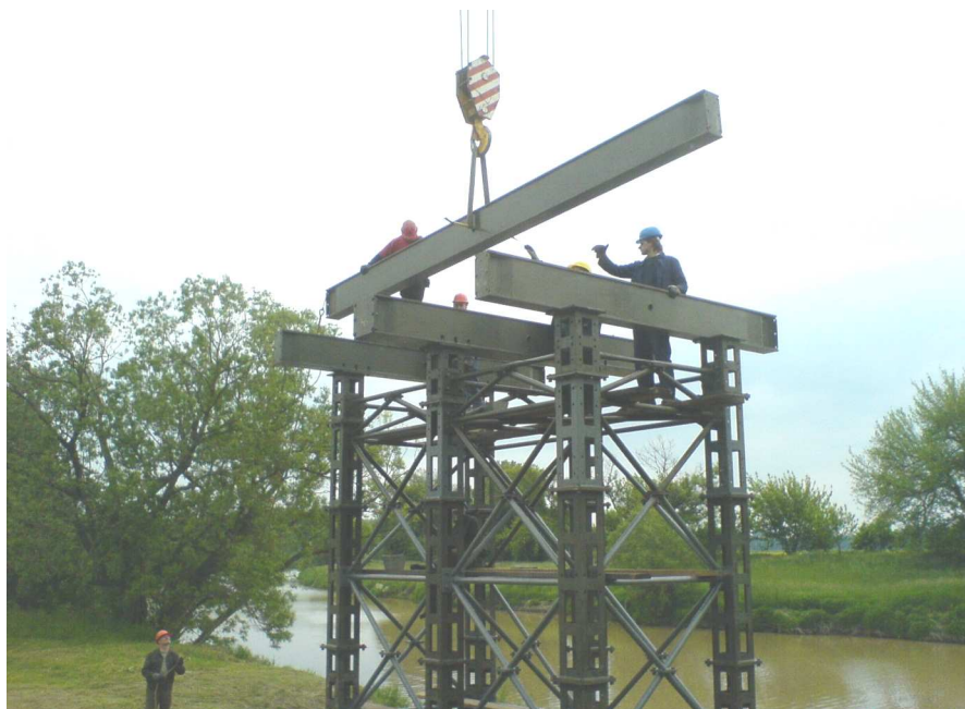
Obr. č. 5.23 Montáž hlavice
