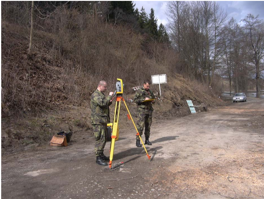
Geodetické zaměření místa stavby
