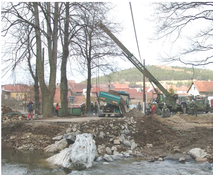
Obr. č. 5.4 Možný způsob úpravy břehu a rozšíření prostoru pro výsuvnou dráhu
