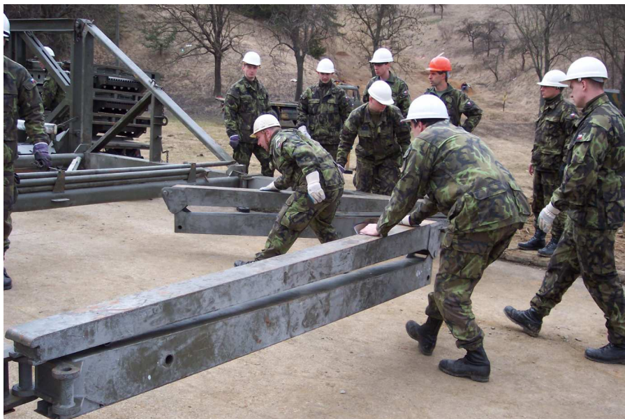
Obr. č. 5.12 Rozložení výsuvného krakorce
