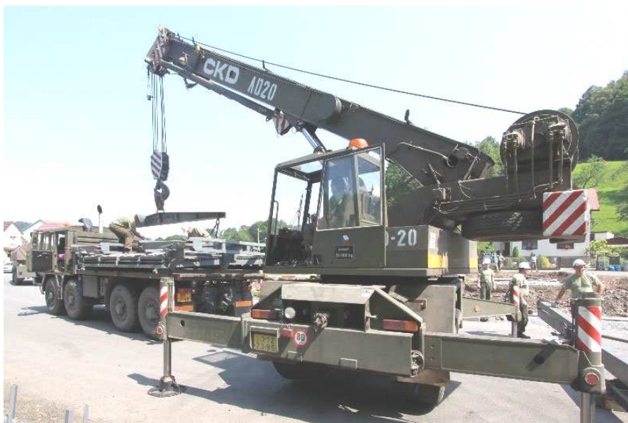
Obr. č. 5.3 Stavba mostu přímo z vozidel
