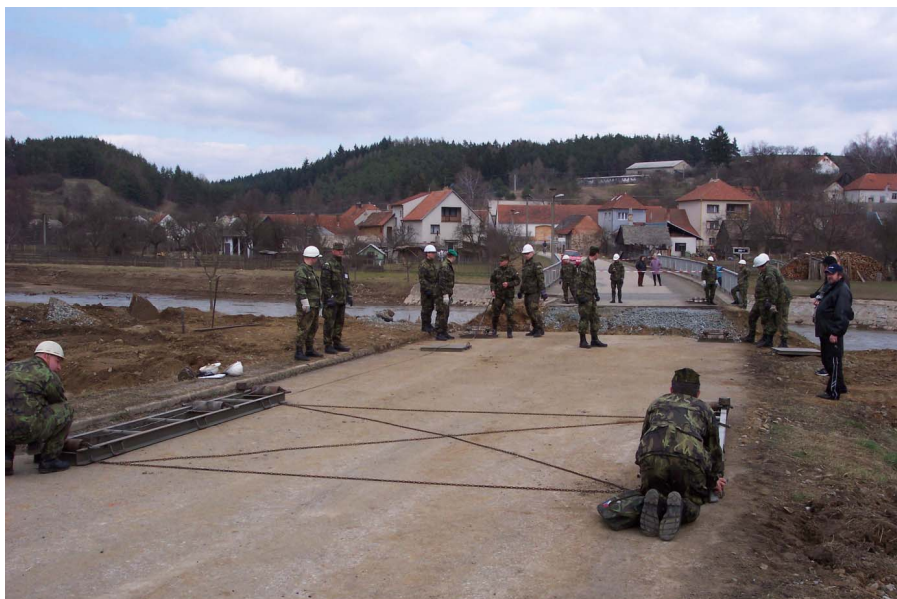
Stavba výsuvné dráhy
