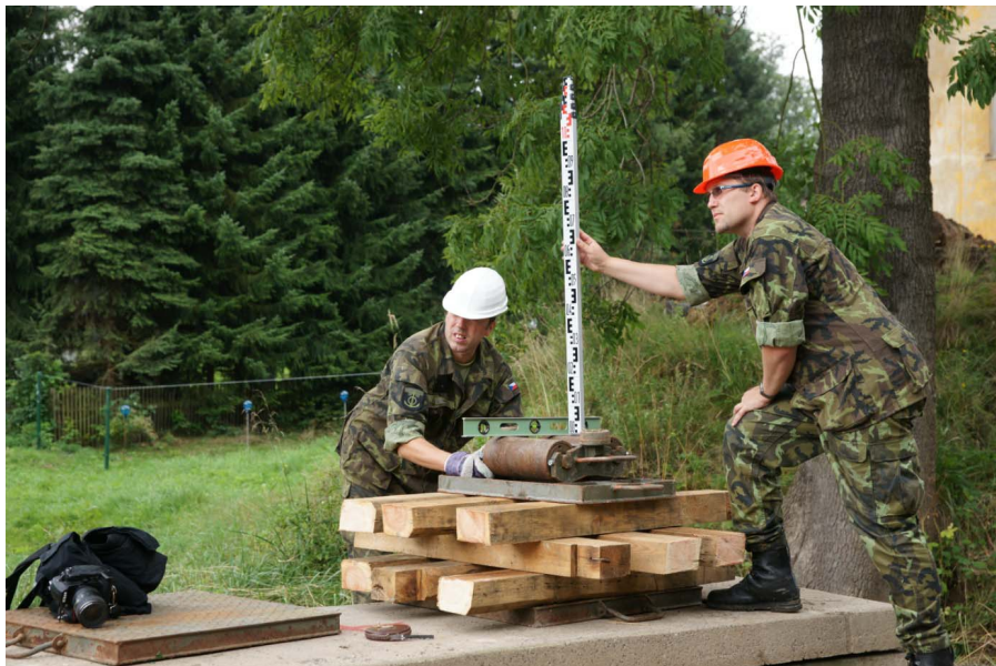
Vyrovnnání výsuvné dráhy
