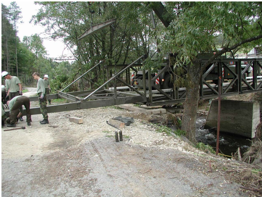
Složení a odpojení krakorce
