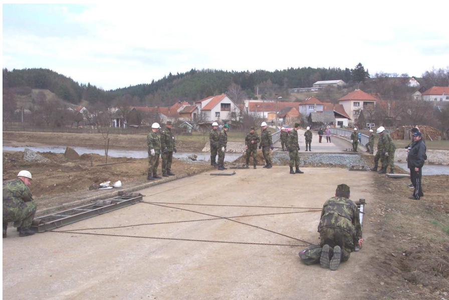
Obr. č. 5.9 Stavba výsuvné dráhy
