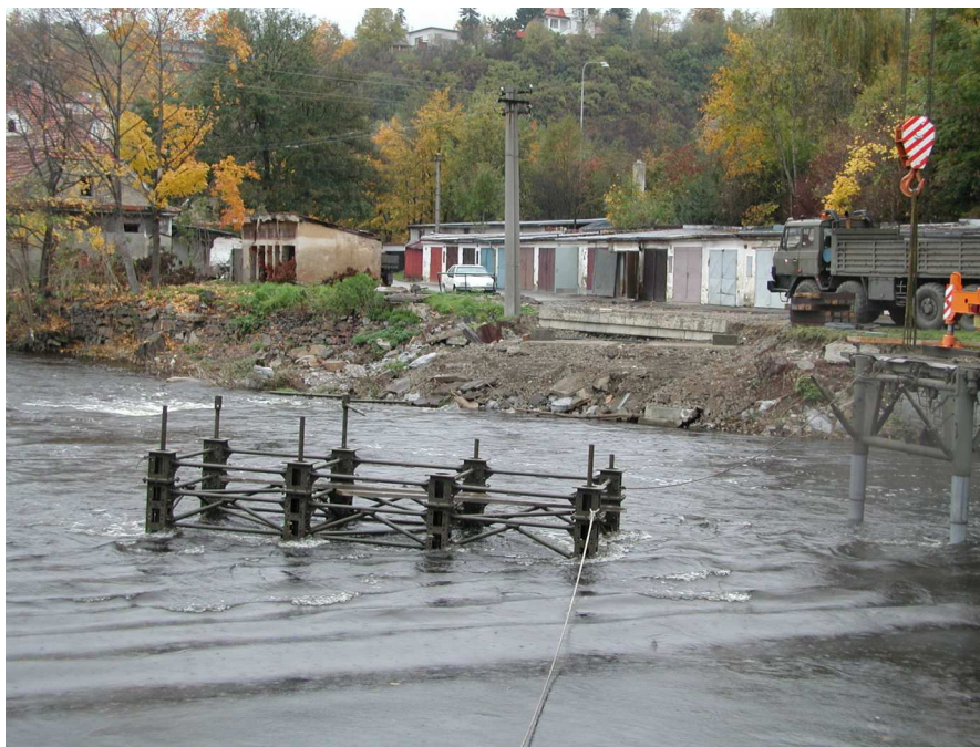
Obr. č. 5.24 Montáž pilíře ve vodě
