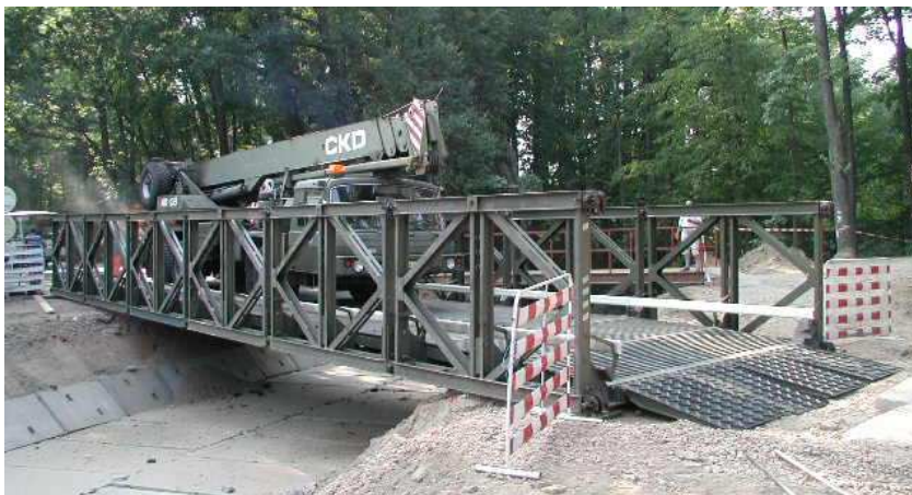
Obr. č. 6.1 Kontrolní přejezd vozidla na mostě MS
