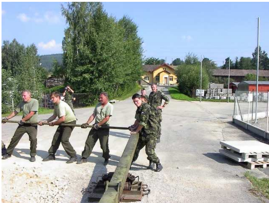
Obr. č. 5.15 Navádění výsuvného krakorce na odlehlém břehu
