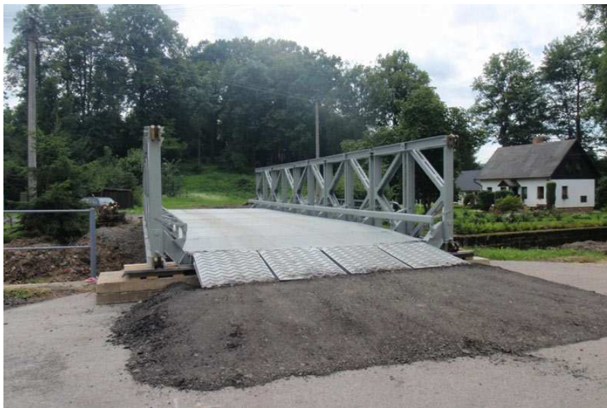
Obr. č. 5.17 Nájezdová rampa pod rampovníky mostu MS
