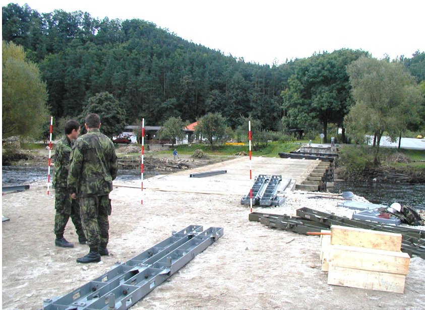
Obr. č. 5.9 Použití výtyček pro vytýčení mostní osy a os hlavních nosníků
