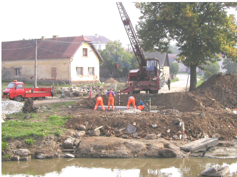
Terénní úpravy pro uložení mostu
