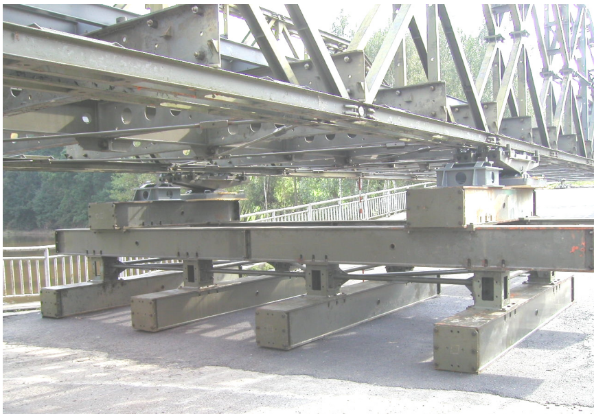
Příprava na uložení na pilíři PIŽMO
