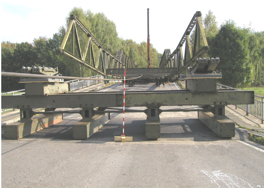
Vysouvání mostu pomocí navijáku
