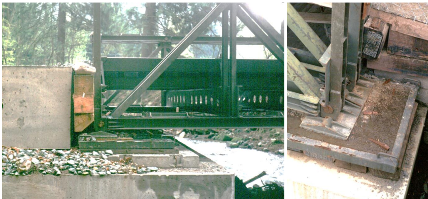
Obr. č. 3.21 Uložení konců mostu na ložiska
