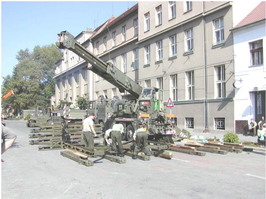
Předmontáž bloků mostu na skládce materiálu
