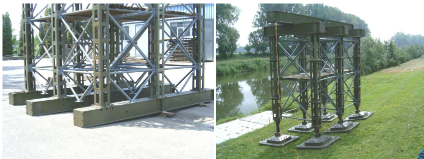
Obr. č. 5.20 Možné způsoby založení pilíře PIŽMO
