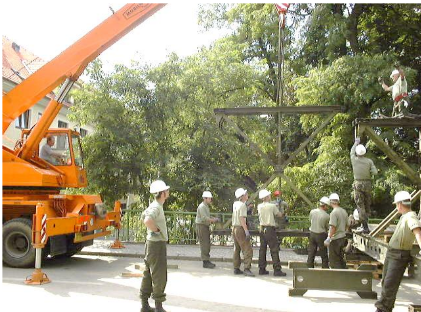
Obr. č. 5.10 Umístění jeřábu za výsuvnou dráhou
