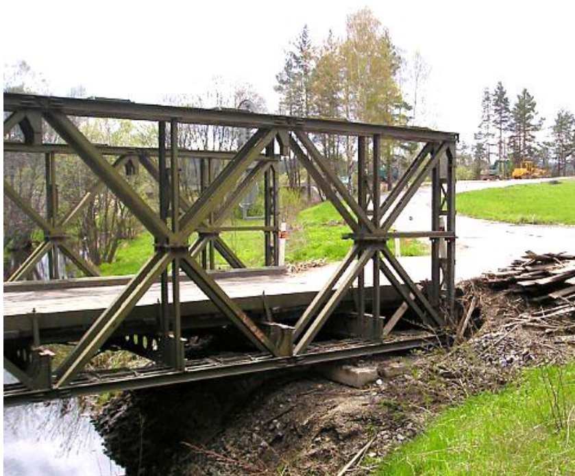
Obr. č. 4.10 Typické uložení mostní konstrukce na narušeném břehu
