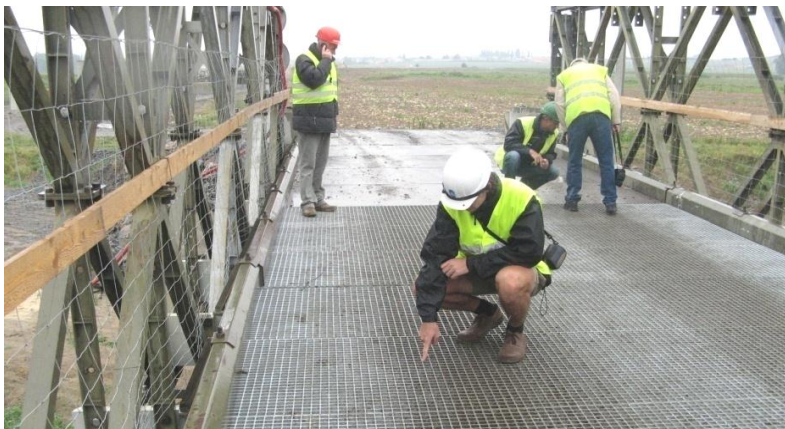
Obr. č. 3.15 Vozovka mostu TMS – 2p2s s ocelovým roštem místo dřevěných mostin
