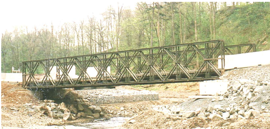
Obr. č. 3.1 Těžká mostová souprava TMS – 2p2s-27m
