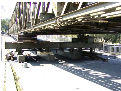
Obr. č. 4.13 Vnitřní podpora konstrukce nad původní mostní konstrukcí
