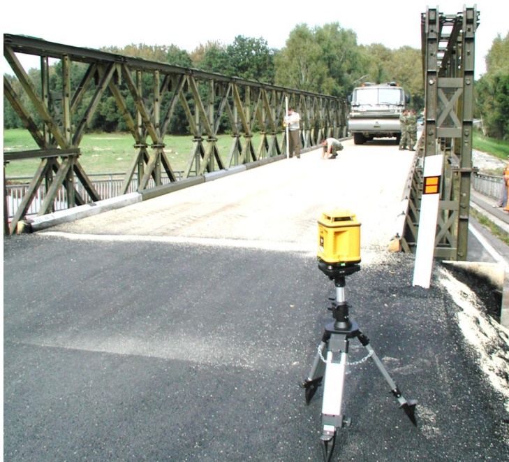
Obr. č. 5.19 Zatěžovací zkouška na mostě TMS u Korázu
