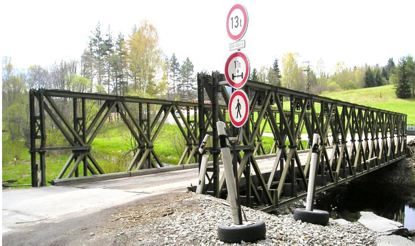
Obr. č. 6.4 Dopravní značení u mostu TMS
