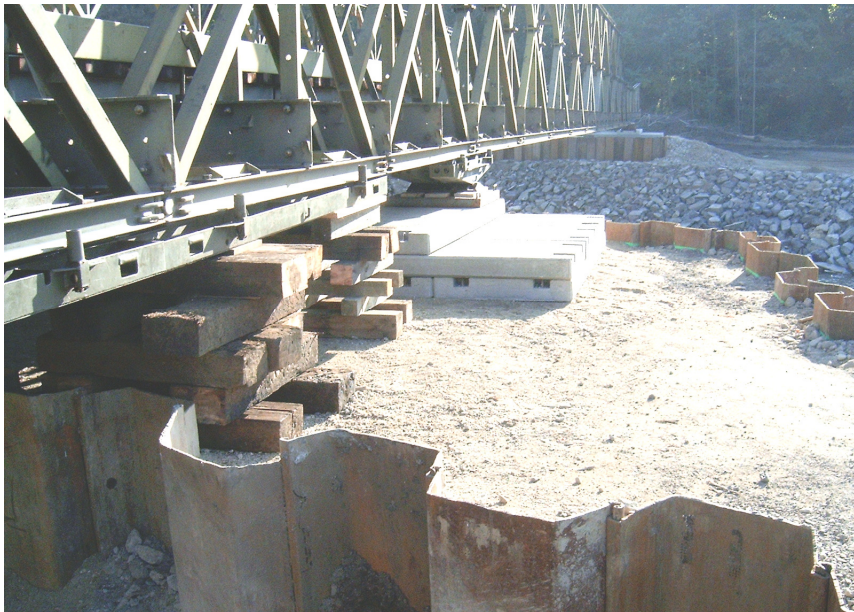
Vysouvání přes betonový pilíř
