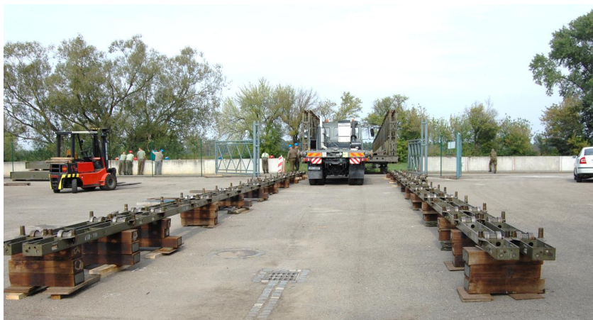
Obr. č. 5.27 Výsuvná dráha postavená pro zpětné zasunutí mostu
