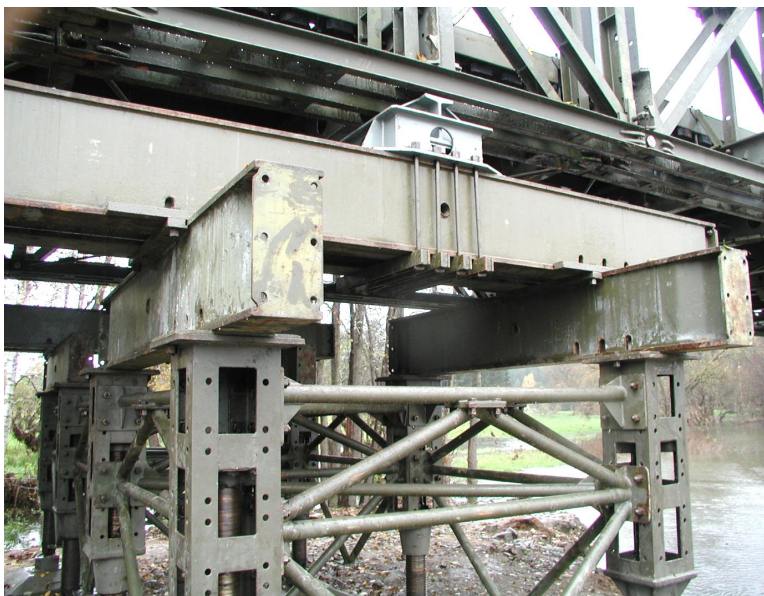
Obr. č. 5.16 Uchycení skříňky pro ložisko pomocí roštového stahovače
