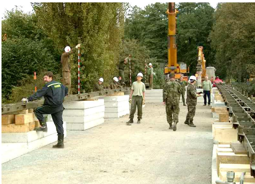
Obr. č. 5.11 Stavba výsuvné dráhy
