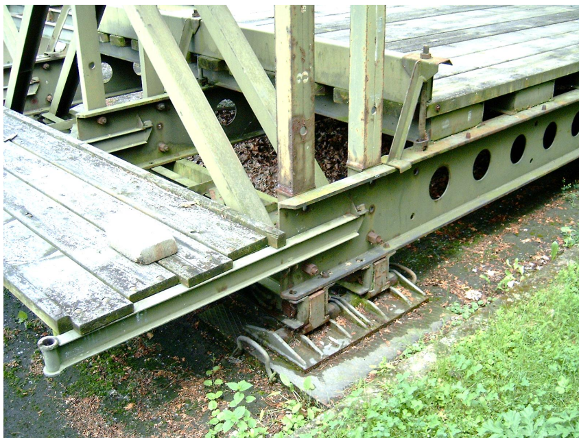
Obr. č. 5.12 Lávka zbudovaná z materiálu TMS vně mostu
