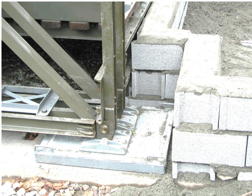
Obr. č. 5.17 Možná varianta vybudování závěrné zídky
