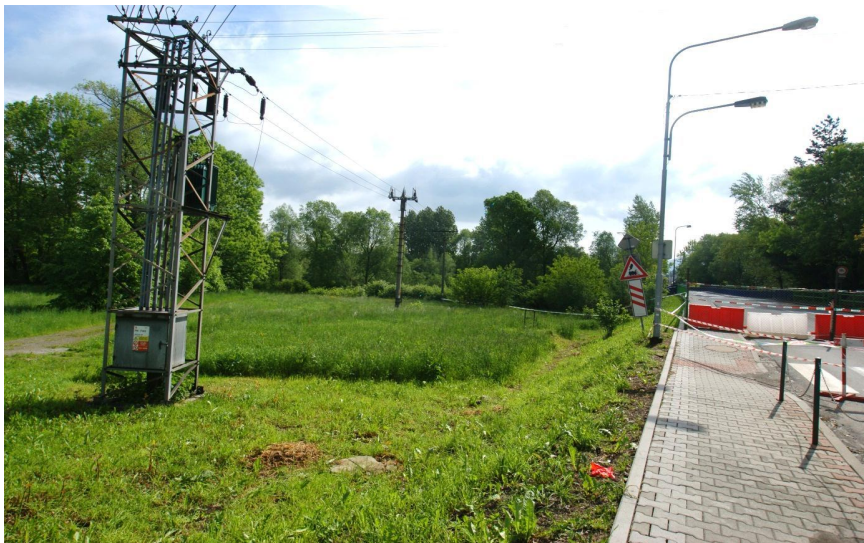
Obr. č. 5.1 Příklad nadzemního vedení v obci Baška, které překáží stavbě mostu TMS
