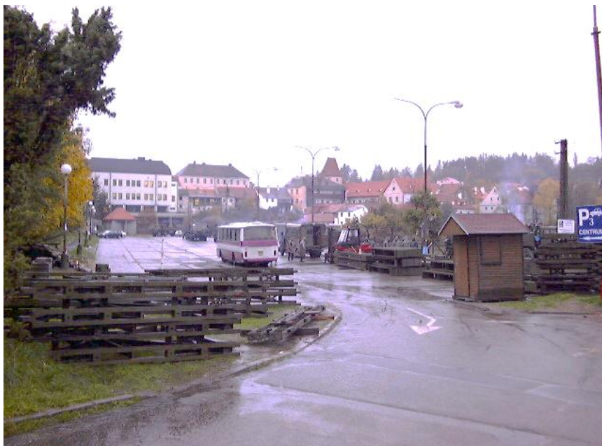
Obr. č. 5.3 Příklad rozsáhlé skládky materiálu při stavbě mostu TMS v Českém Krumlově
