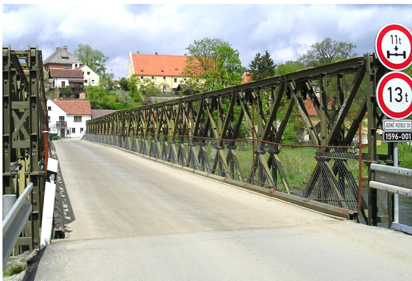
Obr. č. 3.12 Dřevěná vozovka mostu TMS – Z2p2s
