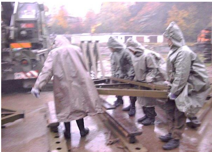
Obr. č. 5.4 Příklad stavby za ztížených klimatických podmínek
