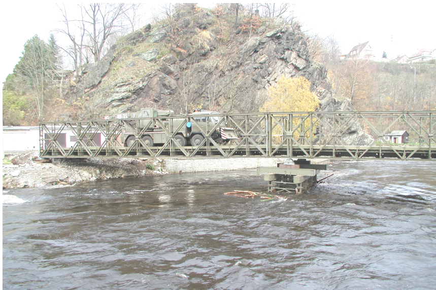
Jedna z poloh vozidla na mostě při zatěžovací zkoušce
