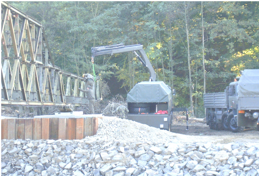
Postupné rozebírání krakorce
