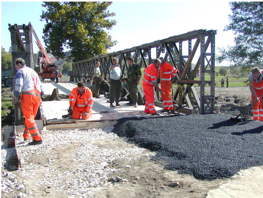
Obr. č. 5.2 Příprava asfaltových nájezdů na most civilní organizací
