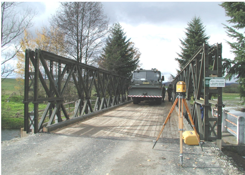
Provádění zatěžovací zkoušky
