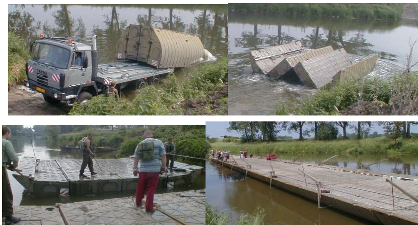
Obr. č. 2.7 Pontonová mostní souprava – technologie stavby
