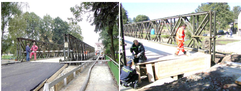
Obr. č. 3.22 Možné řešení dřevěné závěrné zídky a nájezdu na most
