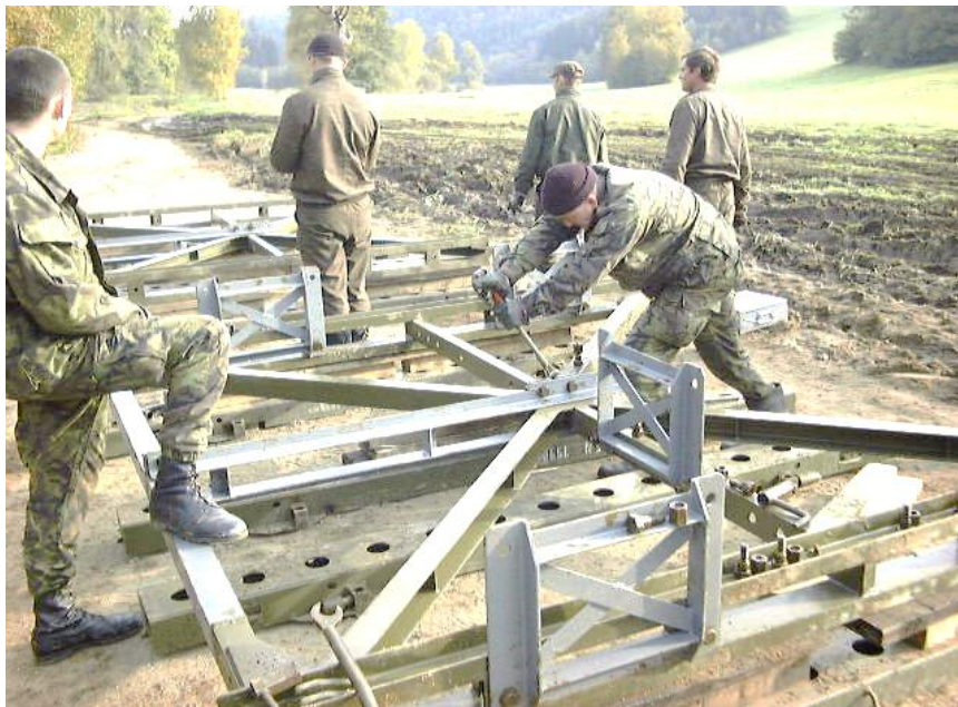
Obr. č. 5.13 Předmontáž bloku hlavního nosníku
