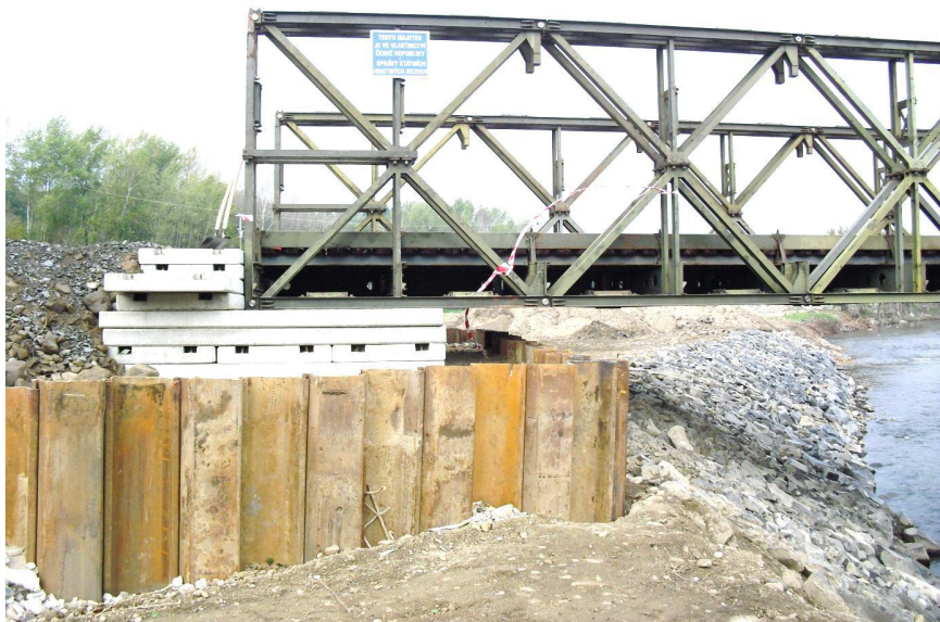
Obr. č. 4.11 Mostní opěra s opatřeními proti zvýšenému průtoku
