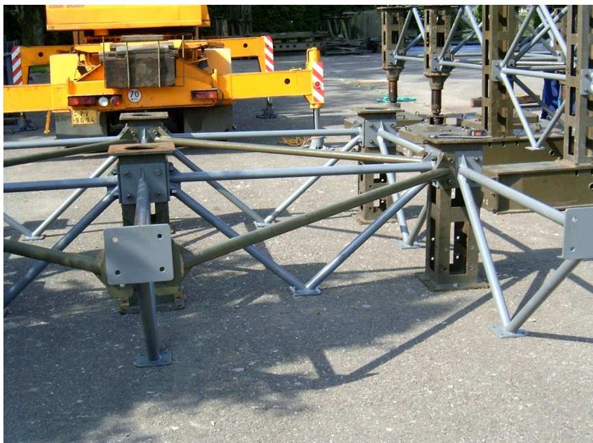
Obr. č. 5.22 Předmontovaný blok na zemi
