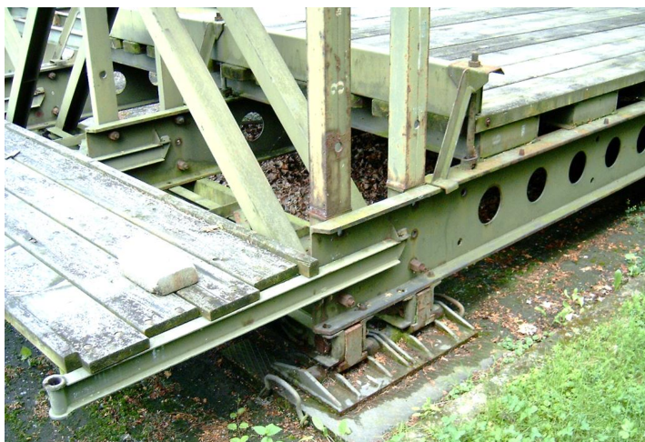
Obr. č. 4.9 Lávka pro pěší vně konstrukce TMS
