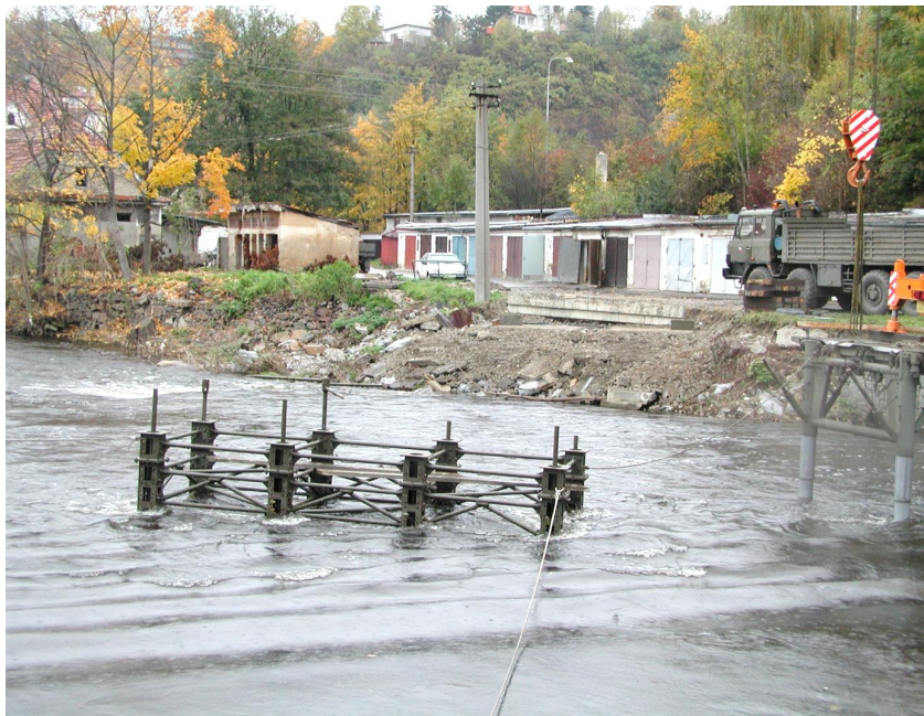
Obr. č. 5.24 Montáž pilíře ve vodě
