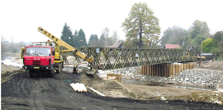
Obr. č. 4.7 Mostní konstrukce uložená na narušeném břehu
