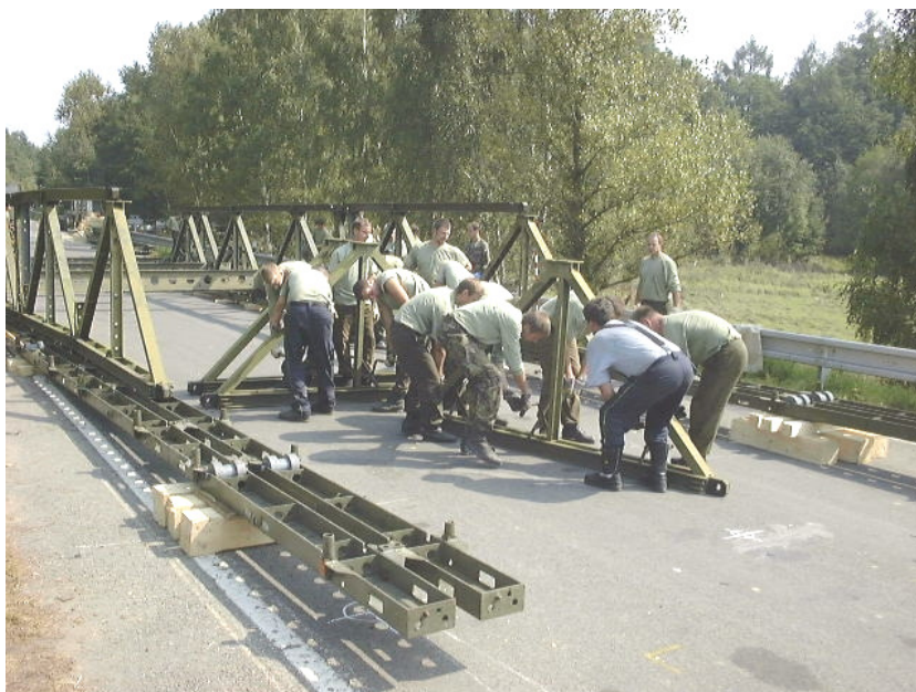
Stavba výsuvného krakorce
