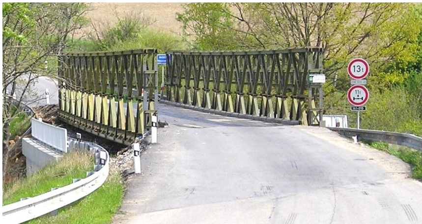
Obr. č. 4.12 Uložení mostní konstrukce nad původní mostní konstrukcí
