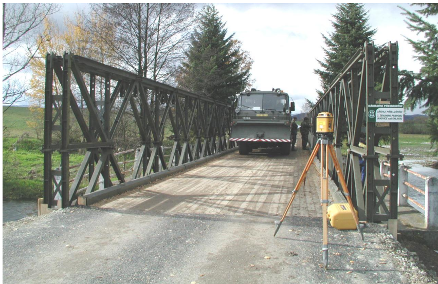
Obr. 6.1 Statická zatěžovací zkouška před uvedením mostu do provozu
