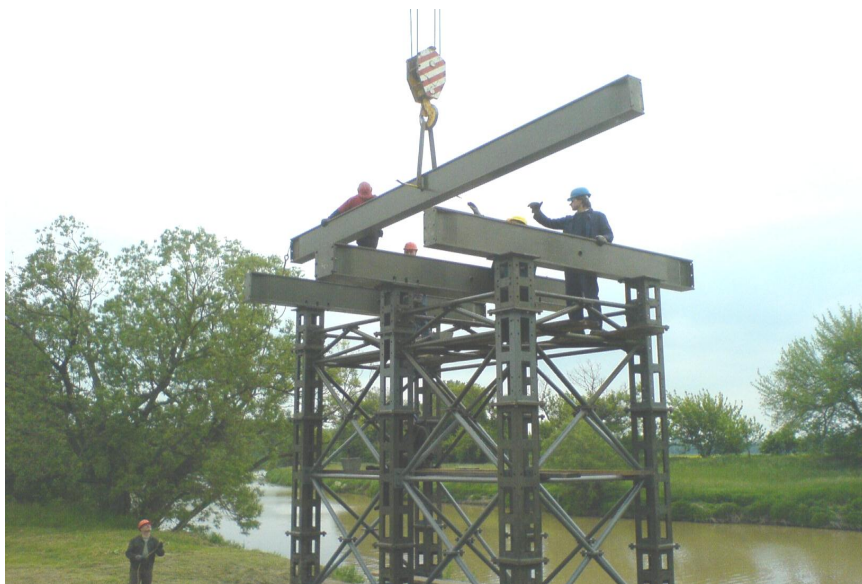
Obr. č. 5.23 Montáž hlavice
