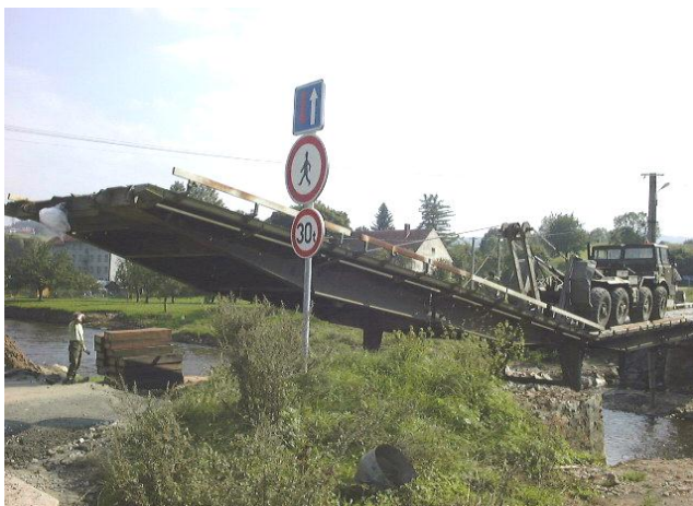
Obr. č. 2.4 Stavba mostu AM-50
