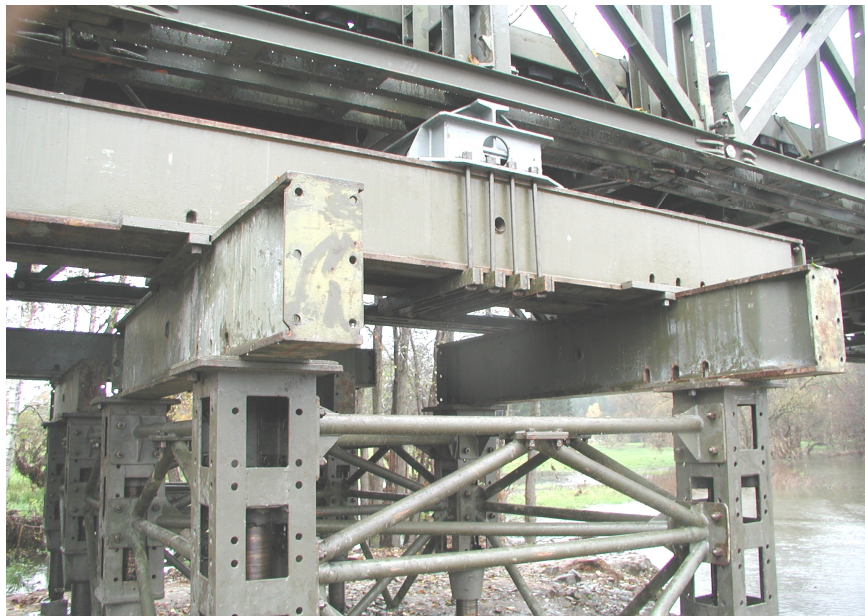
Uložení mostu na pilíři PIŽMO
