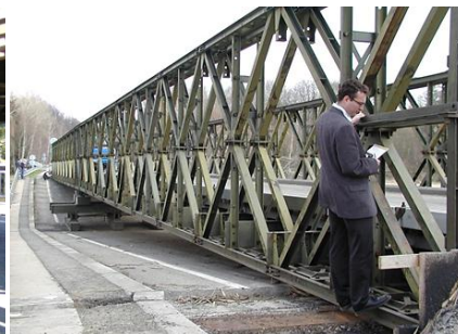
Obr. č. 4.13 Vnitřní podpora konstrukce nad původní mostní konstrukcí
