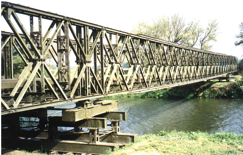
Obr. č. 3.4 Typický vícepolový most ze soupravy TMS, nejdelší pole má zesílené pásy
