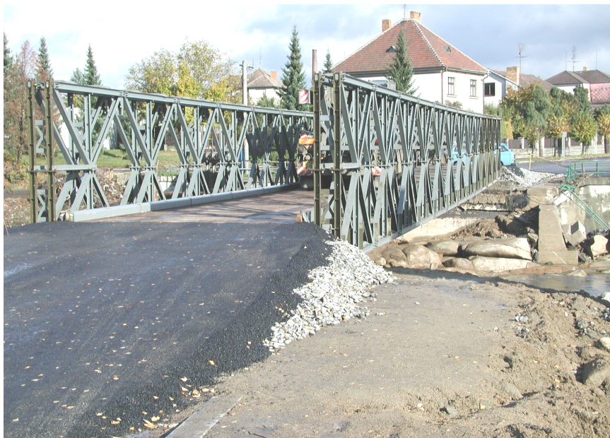
Nájezdové rampy na most
