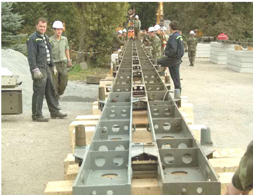
Vyrovnání výsuvné dráhy
