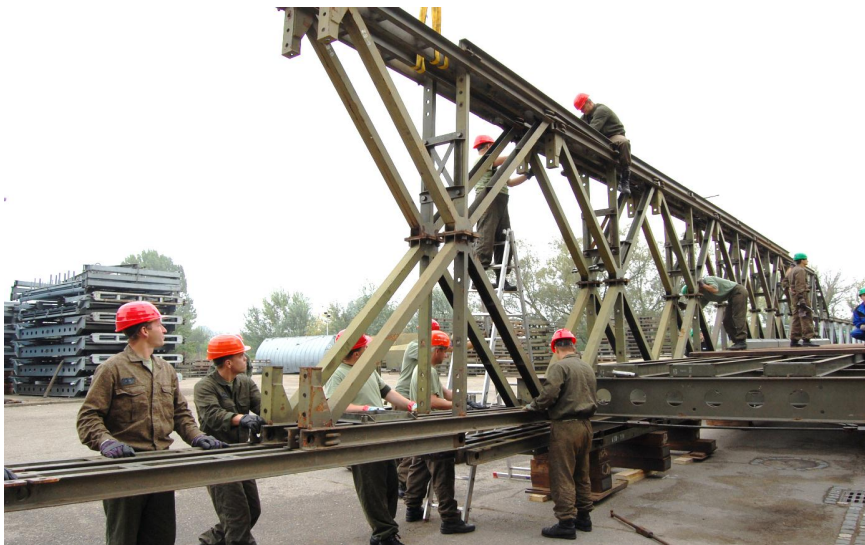
Obr. č. 5.28 Demontáž bloku 2p2sz hlavního nosníku
