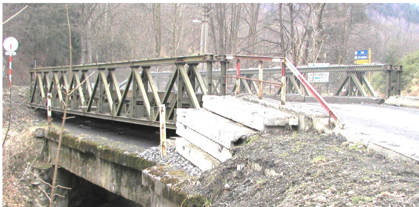
Obr. č. 3.2 Typický jednatrový most ze soupravy TMS 1p2s-18m
