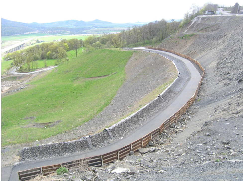
Dokumentační bod č. 6: pohled na JZ na sanovanou odlučnou oblast sesuvu z června 2013 (foto J. Klimeš, duben 2016).
