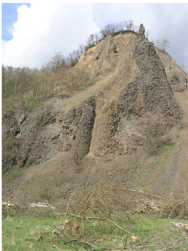
Dokumentační bod č. 12b: pohled na aktivní odvalové řízení (ve středu fotografie) a okolní starou lomovou stěnu, která je silně náchylná ke svahovým pohybům typu řízení (foto J. Klimeš, duben 2016).
