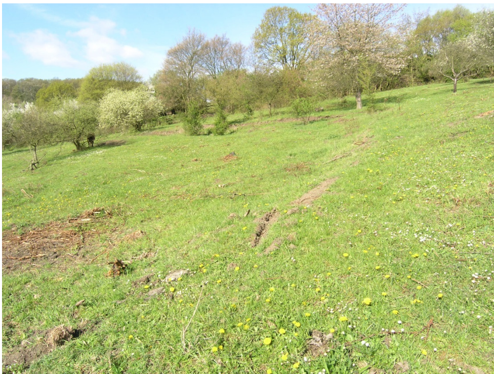
Dokumentační bod č. 20: pohled na odlučnou stěnu aktivního sesuvu (foto J. Klimeš, duben 2016).
