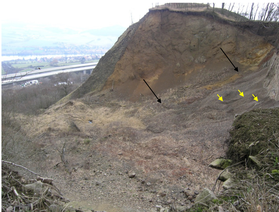
Dokumentační bod č. 12a: pohled do odlučné oblasti aktivního sesuvu směrem na JV. Černé šipky vymezují dílčí, aktivní sesuv (odlučnou oblast a akumulaci); žluté šipky ukazují průběh odlučné stěny dalšího sesuvu, která je možná v iniciálním stádiu. Vlevo, mezi suchou travou je patrný pramen (foto J. Klimeš, duben 2016).
