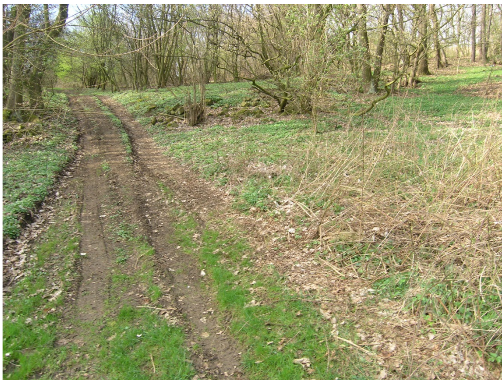
Dokumentační bod č. 18a: hlavní odlučná stěna dočasně uklidněného sesuvu u jeho J omezení, pohled na J (foto J. Klimeš, duben 2016).
