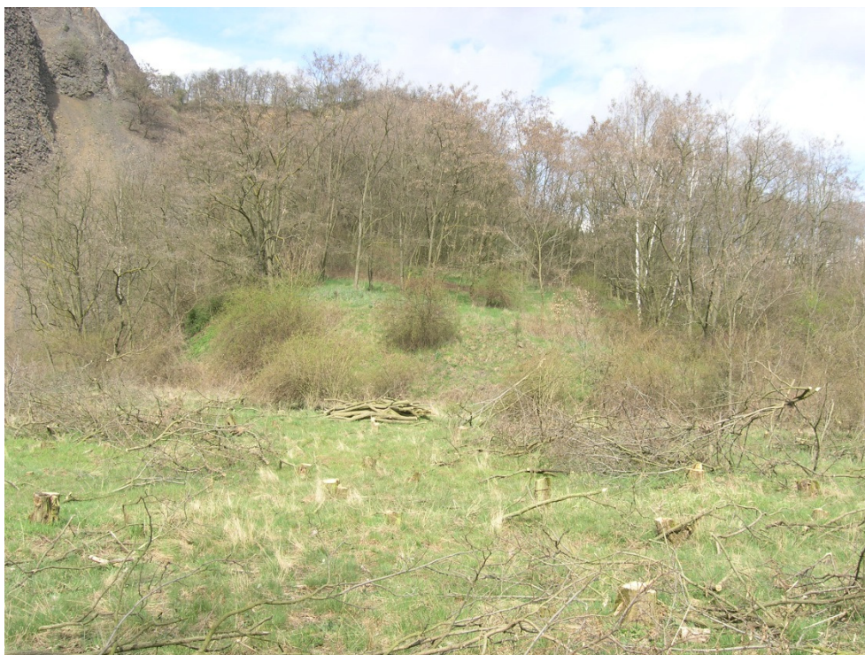
Dokumentační bod č. 12a: pohled na SZ na starší akumulaci dočasně uklidněného sesuvu, který vznikl v roce 1969 a byl později reaktivován sesuvem v současné době vymalovaným jako aktivní (foto J. Klimeš, duben 2016).
