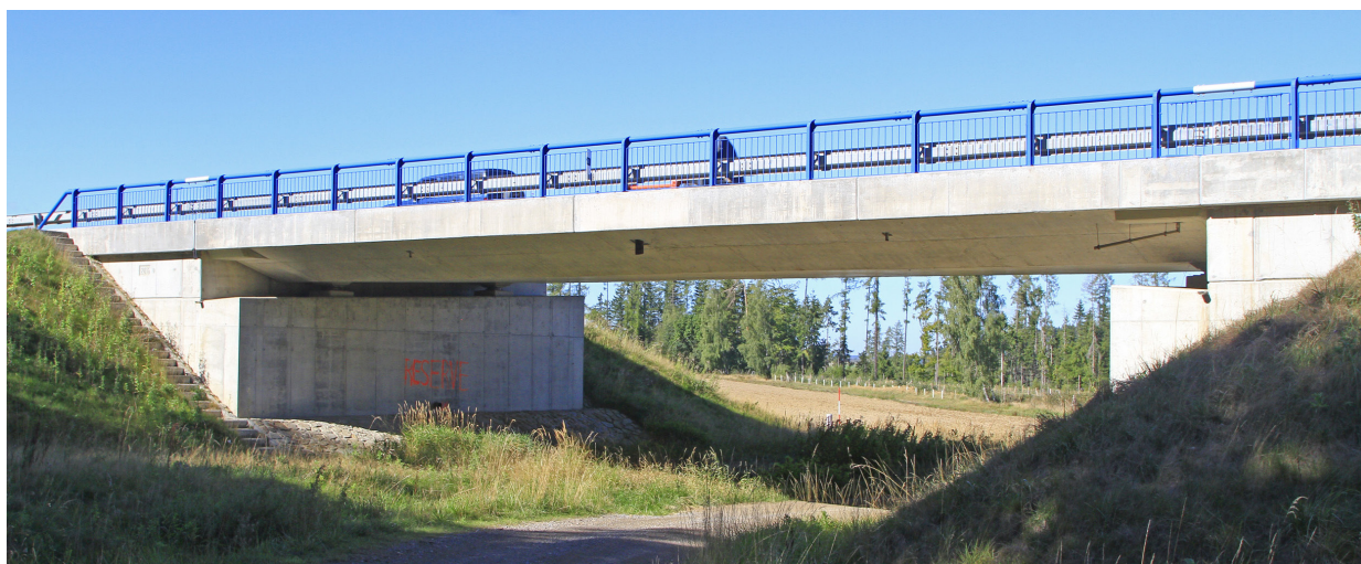
Most přes polní cestu rozšířený (P4)
