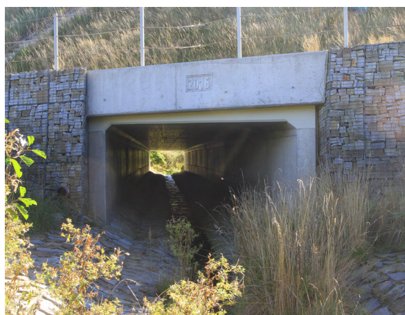
Rámový propustek (P2)
