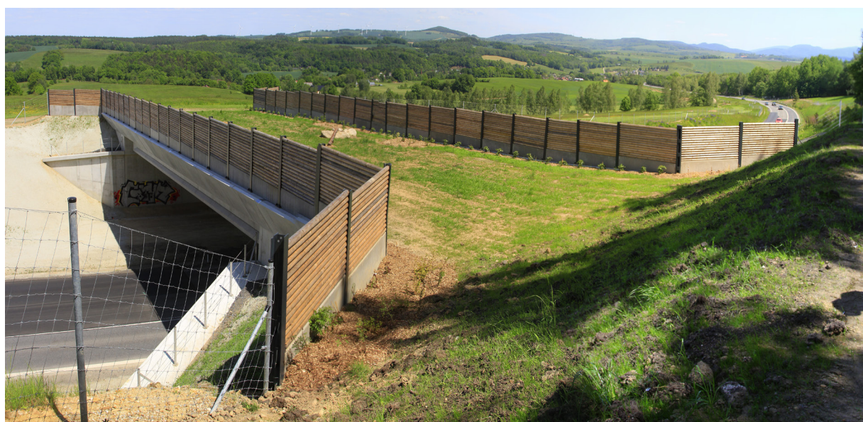
Obr. 25. Ekodukt Rozkoš na silnici I/13 u Liberce
