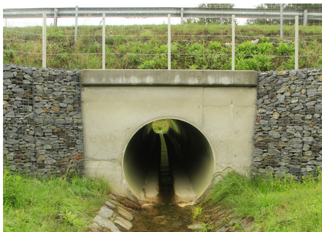
Trubní propustek se suchou cestou (P1)
