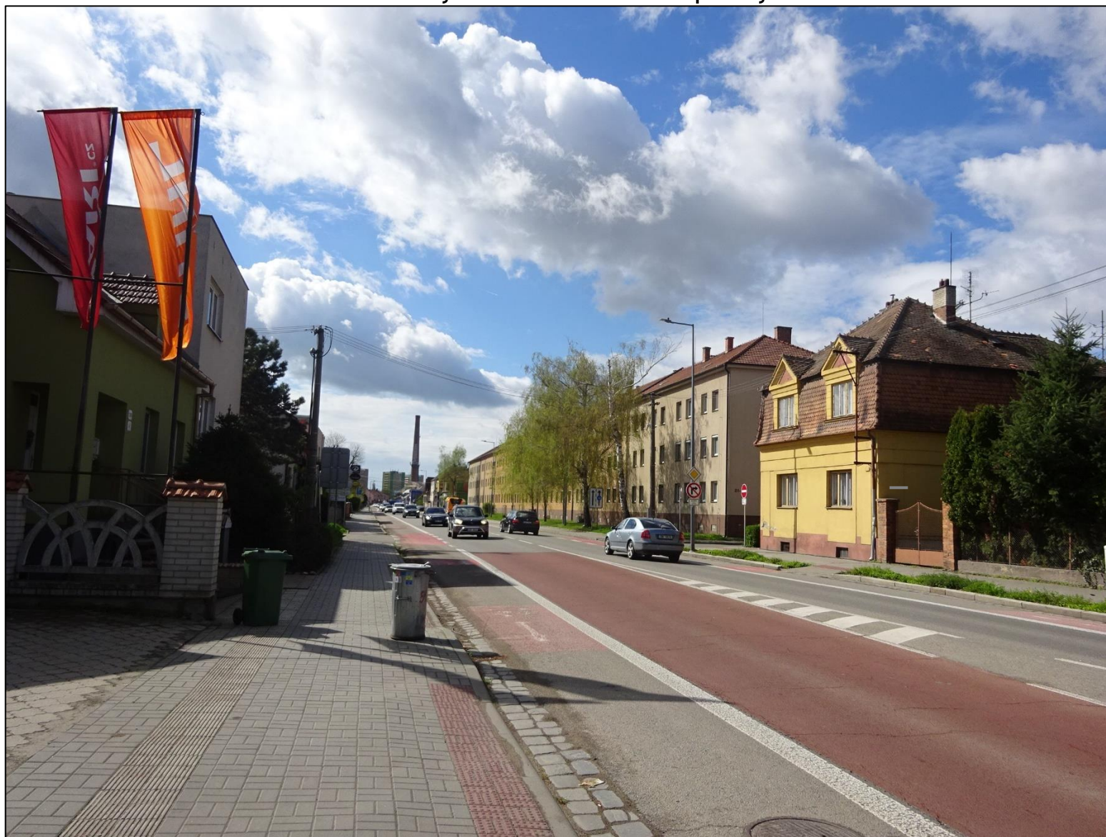
Obr. 10: Fotodokumentace zástavby v okolí kritického místa priority I v Břeclavi v ulici Lidická
