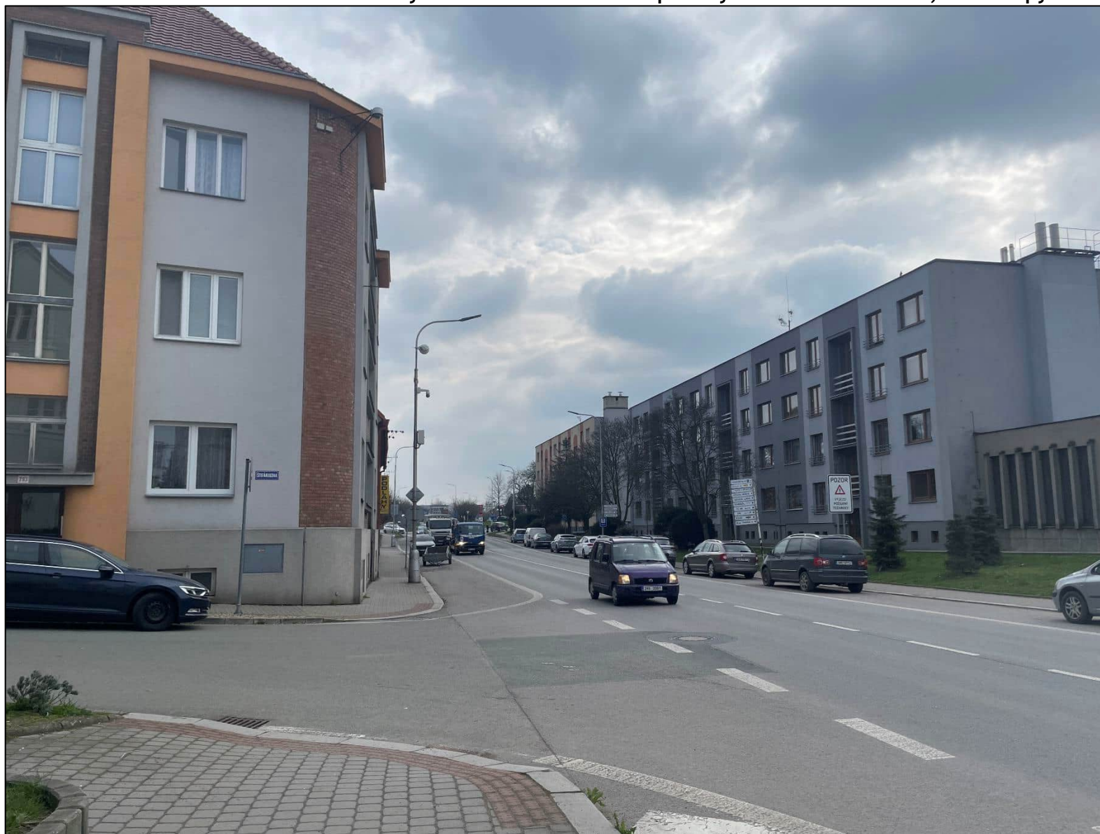
Obr. 19: Fotodokumentace zástavby v okolí kritického místa priority I v Kostelci nad Ohří, ul. Příkopy
