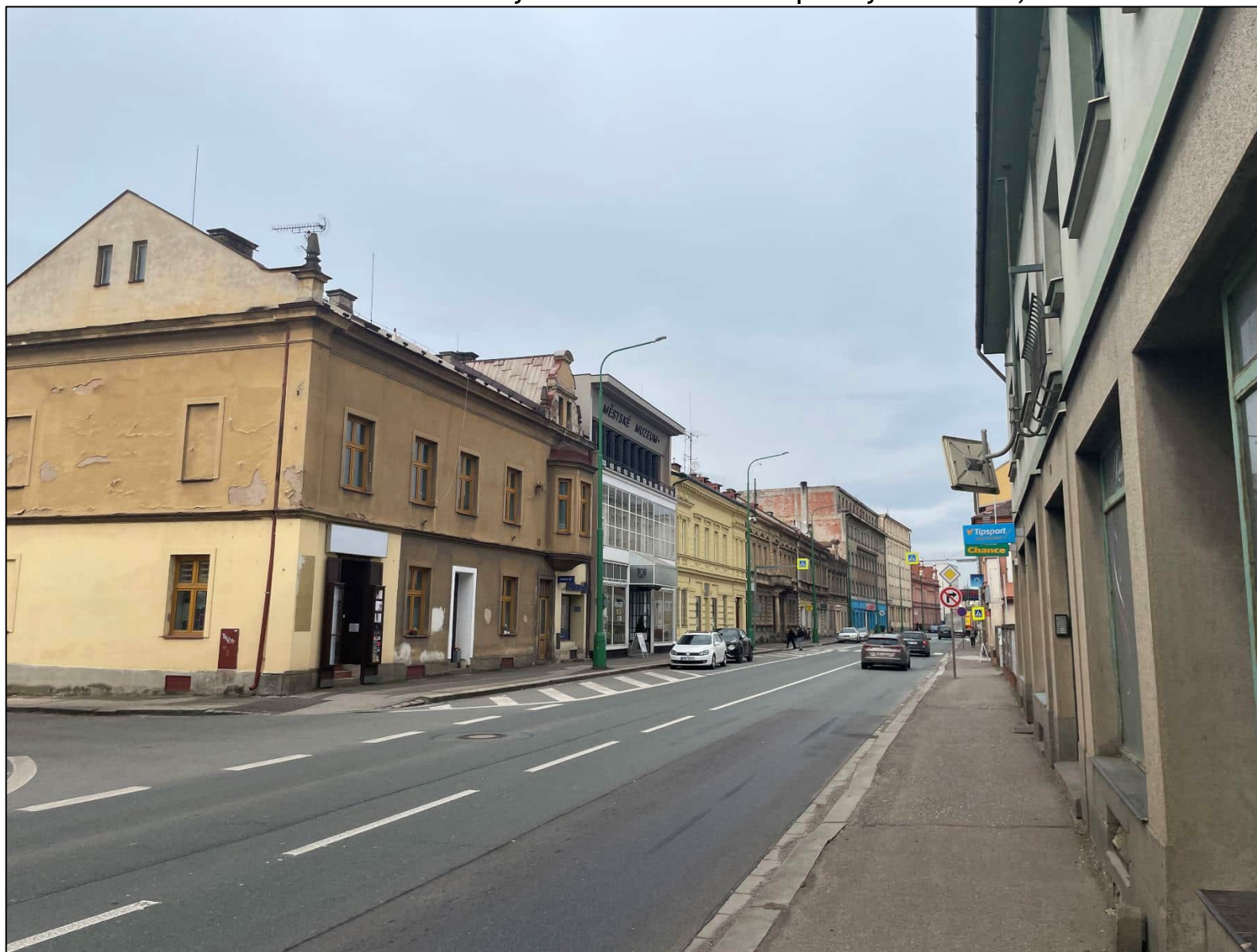
Obr. 15: Fotodokumentace zástavby v okolí kritického místa priority I v Jaroměři, ul. Husova
