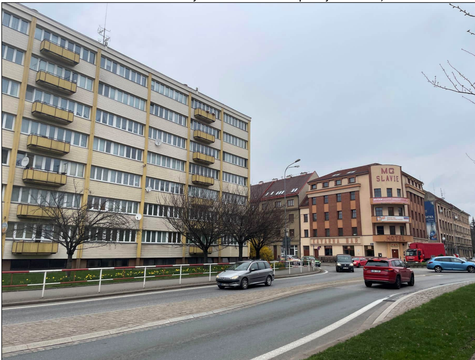
Obr. 25: Fotodokumentace zástavby v okolí kritického místa priority I v Náchodě, ul. Pražská
