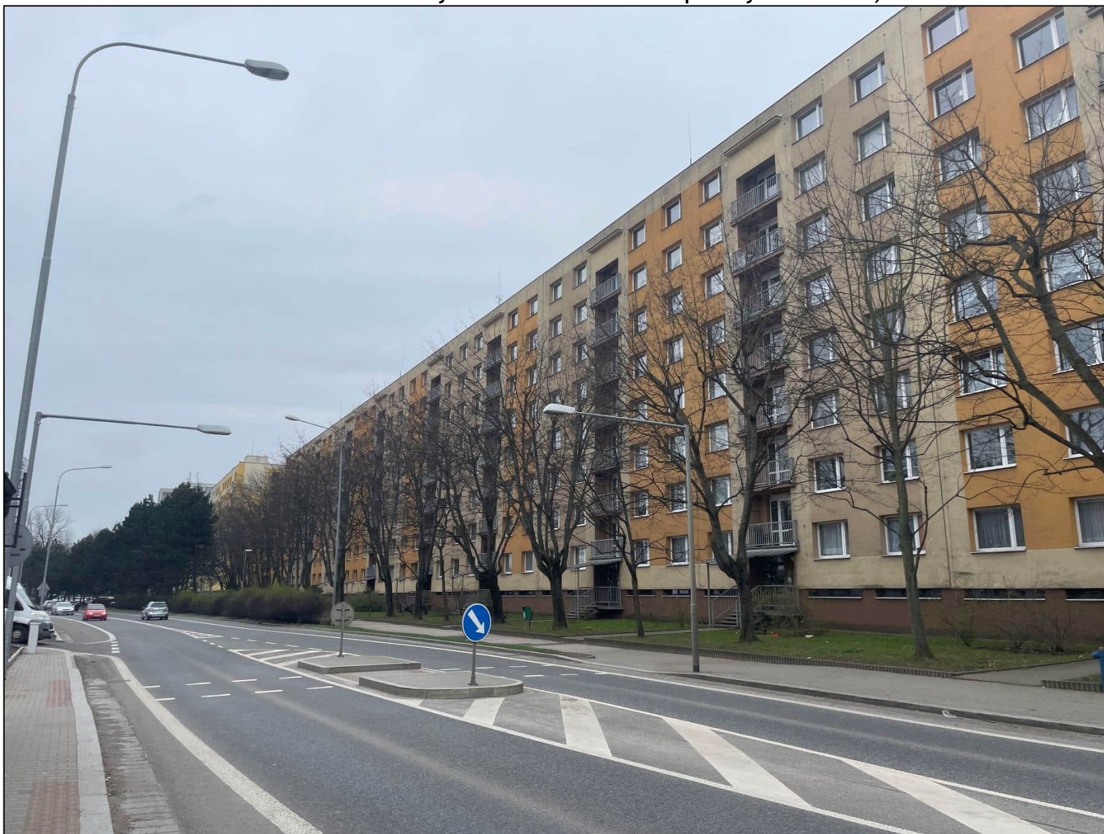
Obr. 21: Fotodokumentace zástavby v okolí kritického místa priority I v Náchodě, ul. Běloveská
