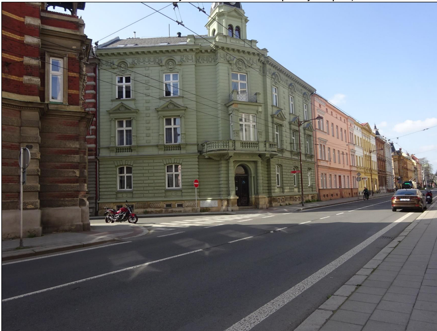
Obr. 19: Fotodokumentace zástavby v okolí kritického místa priority I v Opavě, ul. Krnovská
