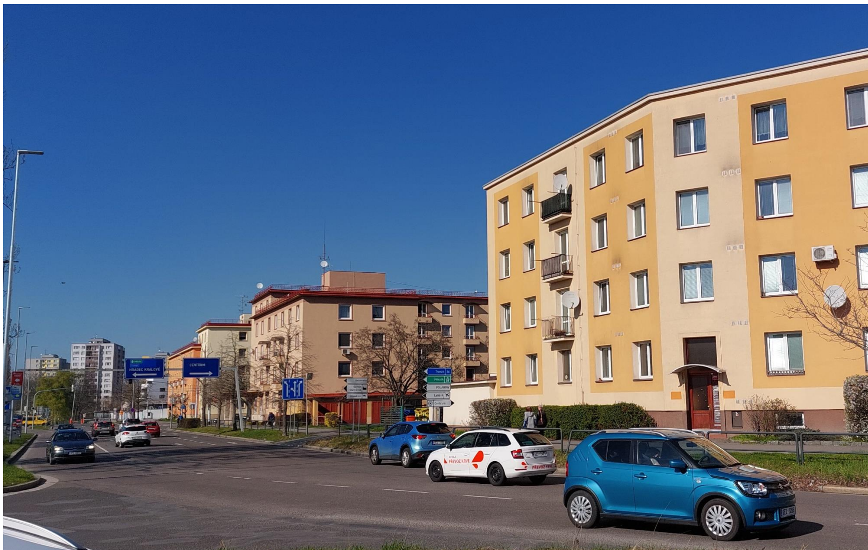
Obr. 15: Fotodokumentace zástavby v okolí kritického místa priority I v Pardubicích, ulice Hlaváčova
