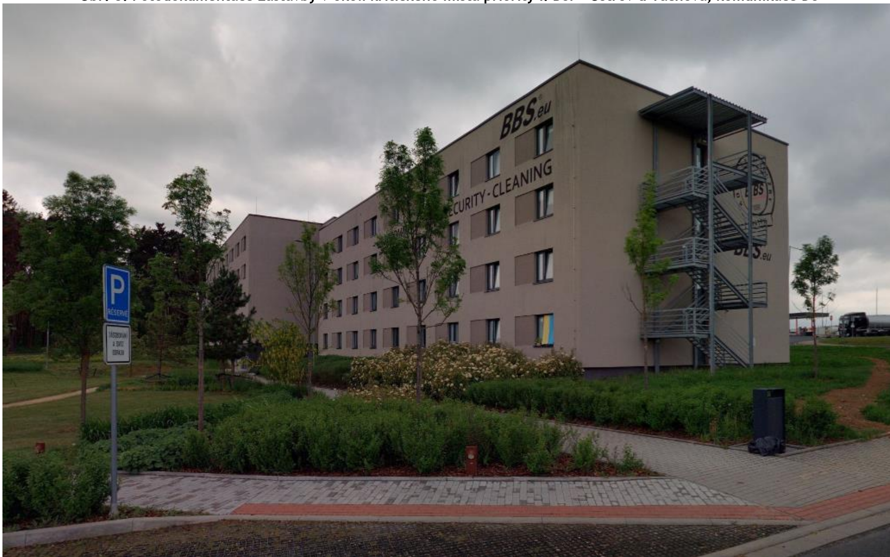
Obr. 8: Fotodokumentace zástavby v okolí kritického místa priority I. Bor - Ostrov u Tachova, komunikace D5
