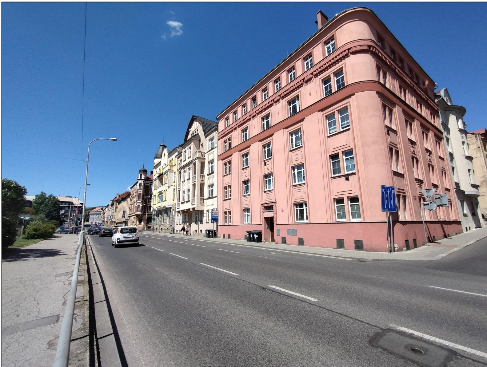
Obr. 17: Fotodokumentace zástavby v okolí kritického místa priority I v Děčíně v ulici Podmokelská
