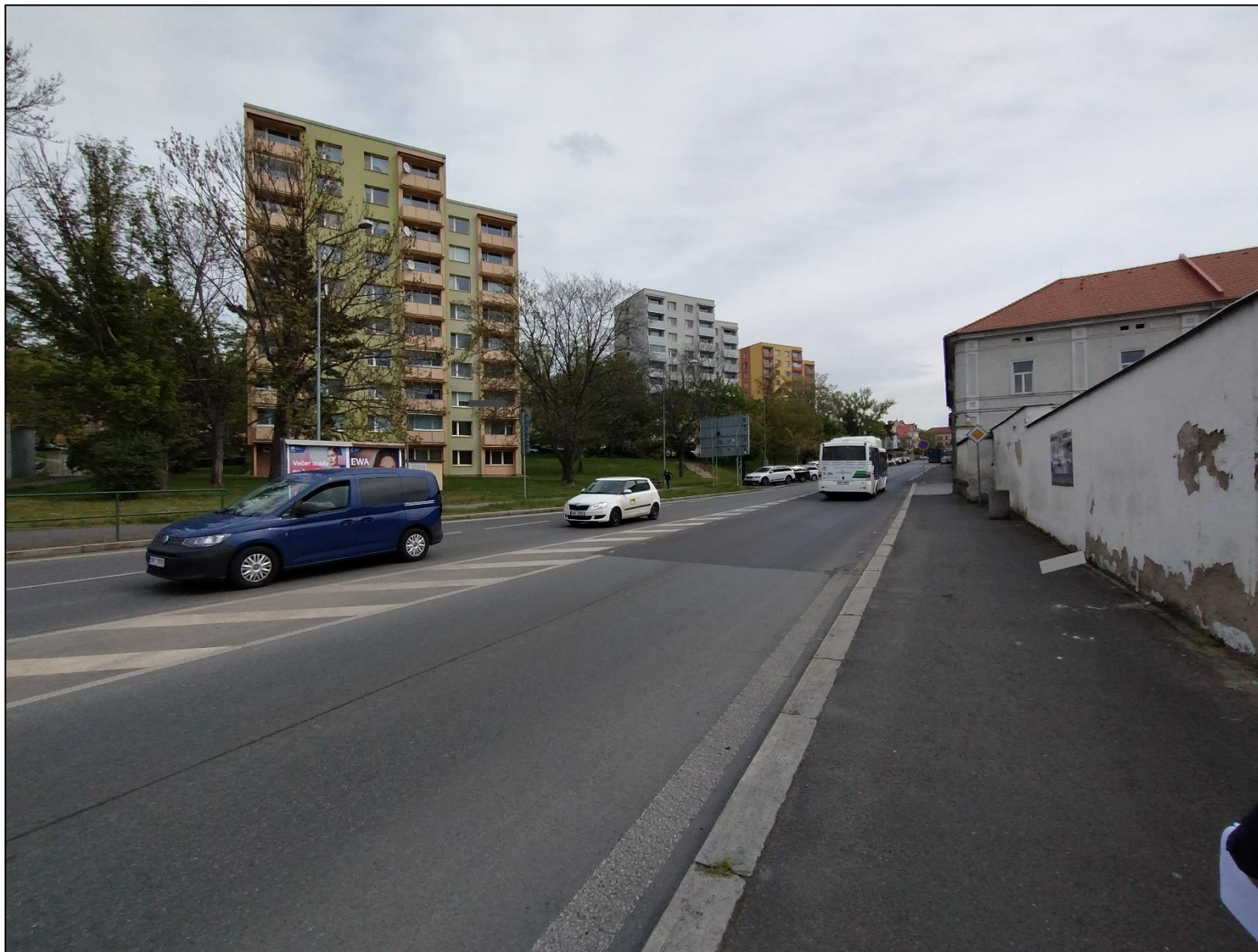
Obr. 20: Fotodokumentace zástavby v okolí kritického místa priority I v Litoměřicích v ulici Na Kocadně
