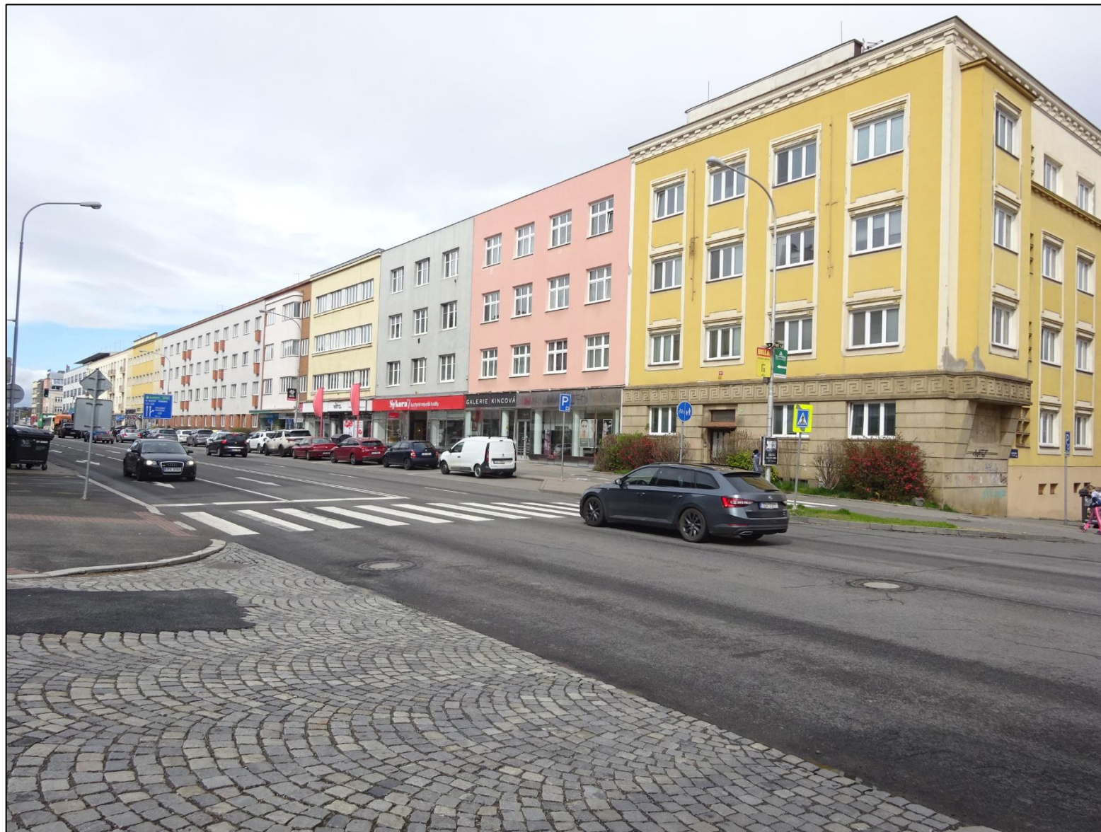
Obr. 10: Fotodokumentace zástavby v okolí kritického místa priority I ve Zlíně, tř. T. Bati, pohled směr západ
