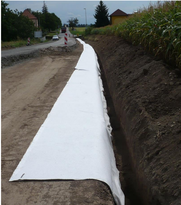
Úspora při podélných výkopech při odvodnění komunikace pomocí drenážního geokompozitu
