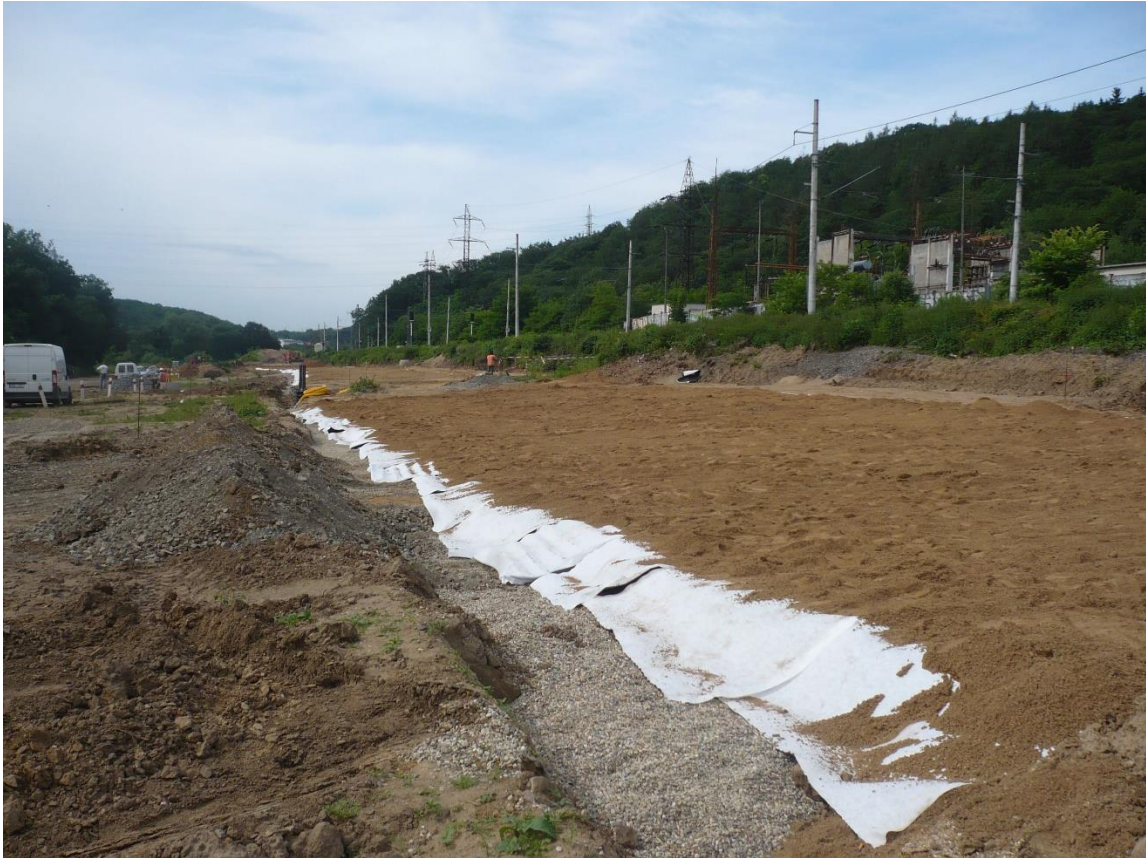
Odvodnění násypového tělesa, geokompozit na bázi náspu
