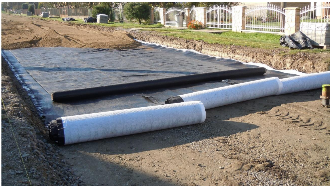
Odvodnění komunikace pomocí drenážního geokompozitu
