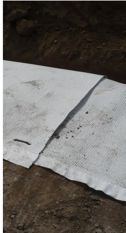
Úspora při podélných výkopech při odvodnění komunikace pomocí drenážního geokompozitu
