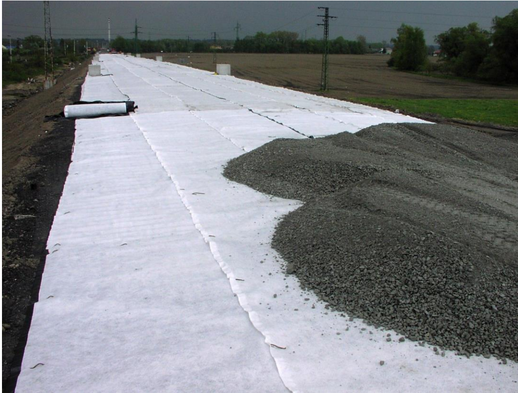
Drenážní geokompozit uložený na pláni tělesa železničního spodku
