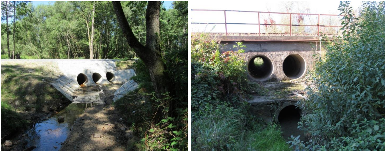
Obr. 5.1 Vícenásobné propustky na pozemní a železniční dopravní komunikaci
