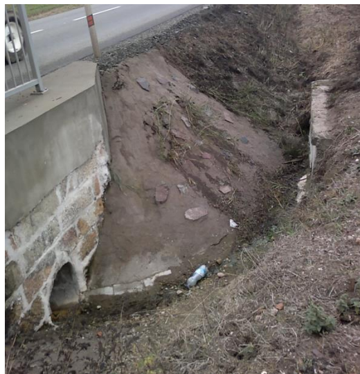
Obr. 5.3 Kolmý nátok do propustku
