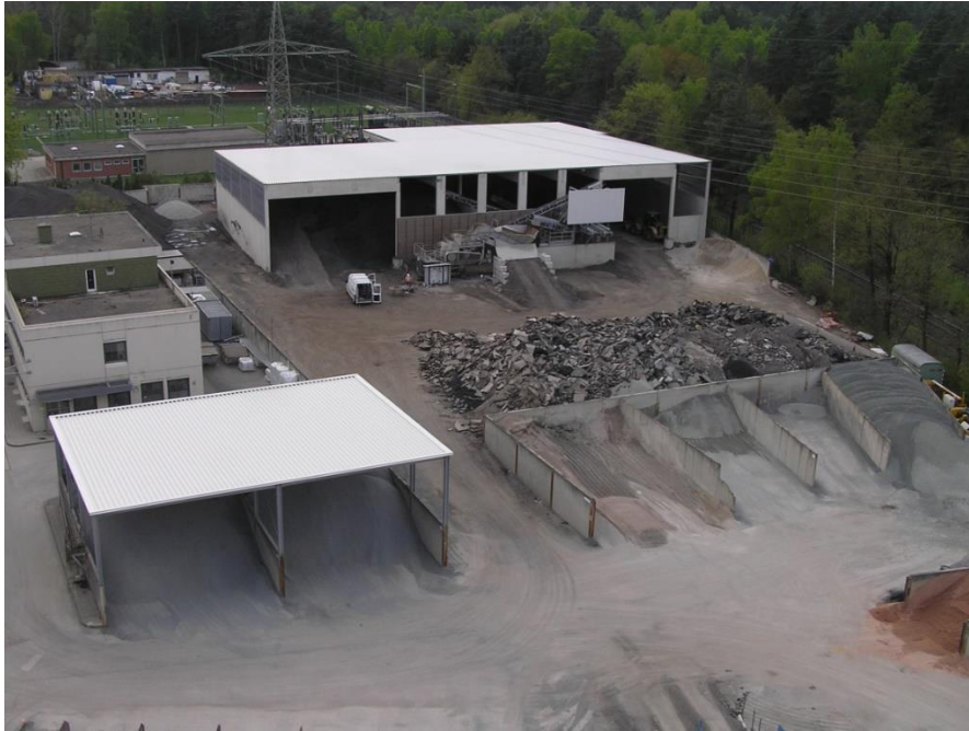
Obrázek 2 Zastřešení skládky předrceného R-materiálu
