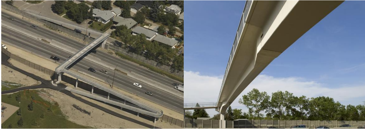
Obr. 14 Lávka pro pěší přes silniční komunikaci, Calgary, Kanada, zdroj [65]
