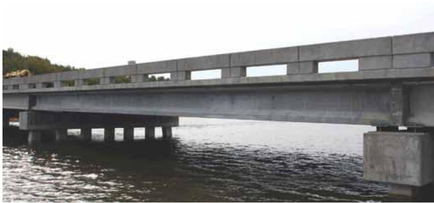
Obr. 26 Silniční most Cat Point Creek Bridge, Virginia, USA
