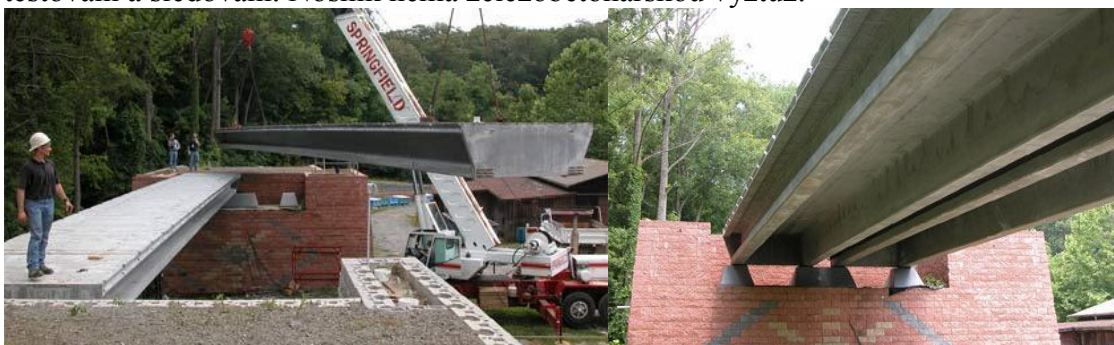
Obr. 28 Zkušební lávka, FHWA laboratoř, Virginie [65]
