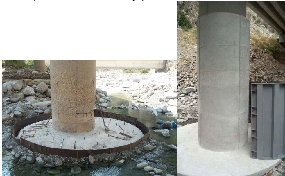
Obr. 41 Rekonstrukce pilířů mostu de Valabres, Francie (zdroj [70])
