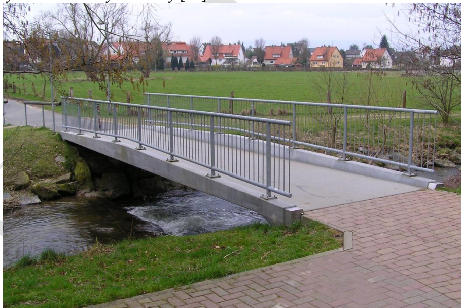
Obr. 23 Cyklo lávka přes řeku Nieste
