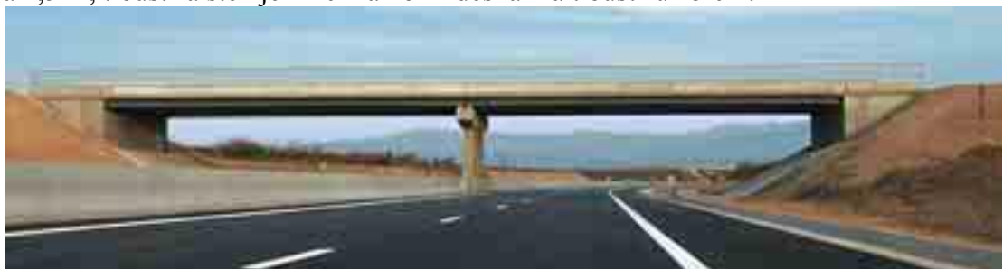
Obr. 11 Silniční most Bourg-lès-Valence, Francie, zdroj [75]
