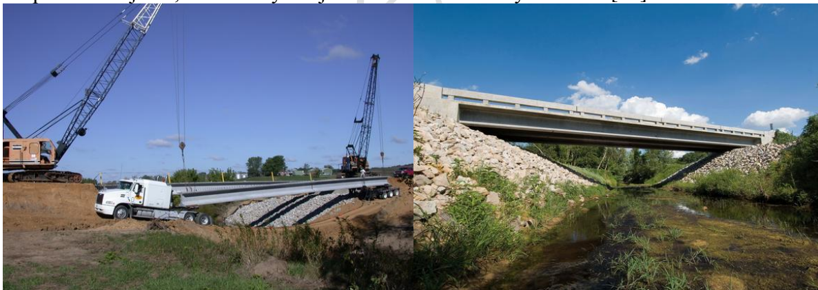
Obr. 25 Silniční most Mars Hill Bridge, Wapello County Iowa, USA
