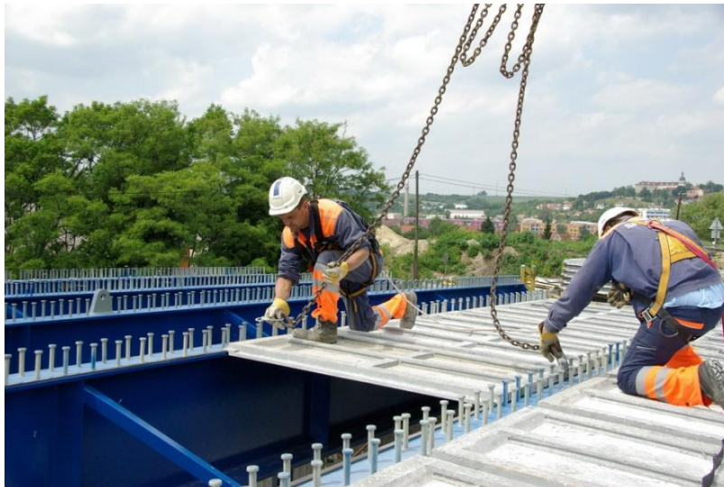
Obr. 5 Instalace desek ztraceného bednění mostovky Benátky nad Jizerou, ČR zdroj [16]
