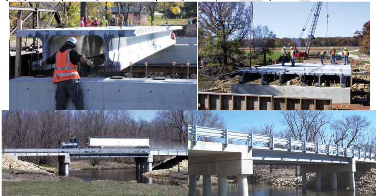
Obr. 27 Silniční most Jakway Park Bridge Iowa, USA, zdroj [79]
