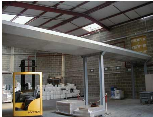
Obr. 7 Lávka v chemické továrně Chryso, Francie, zdroj [72]
