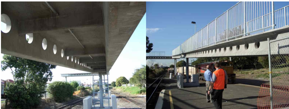
Obr. 22 Lávka pro pěší přes železniční stanice, Papatoetoe, Nový Zéland, (zdroj [70], [76])
