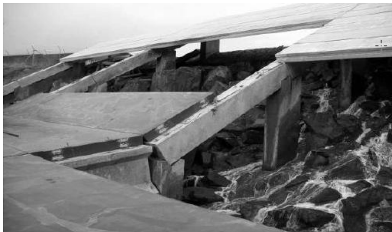
Obr. 37 Zakrytí jezů u elektrárny Eraring Power Station, Austrálie (zdroj [76])
