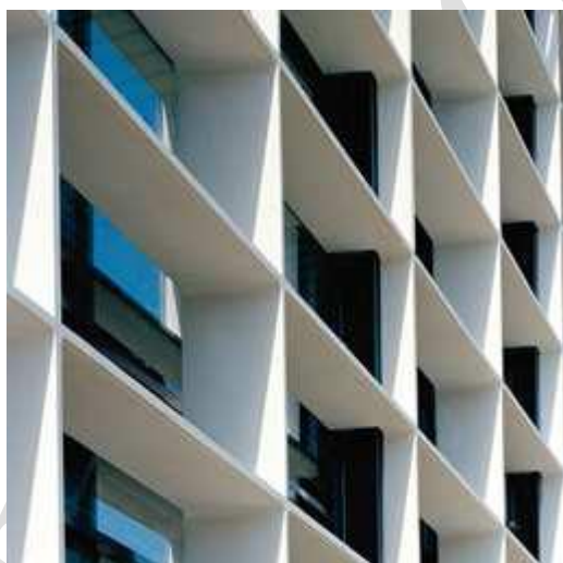
Obr. 47 Sluneční clony na fasádě plaveckého bazénu Clichy Swimming Pool Complex [76]
