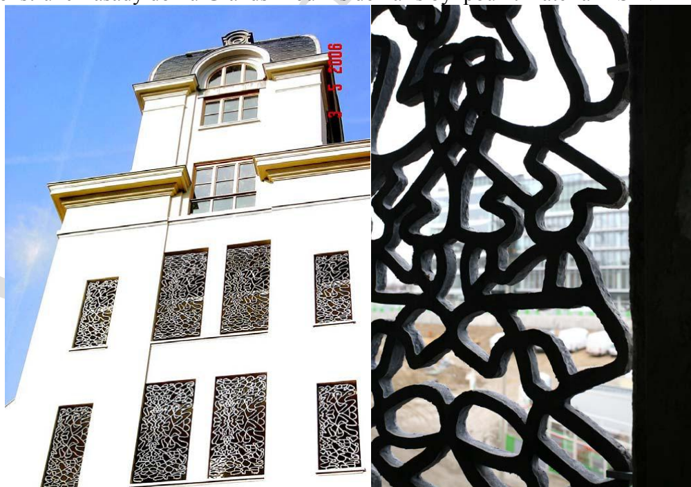
Obr. 42 Rekonstrukce fasády domu GrandsMoulins, Paříž, Francie (zdroj [70])
