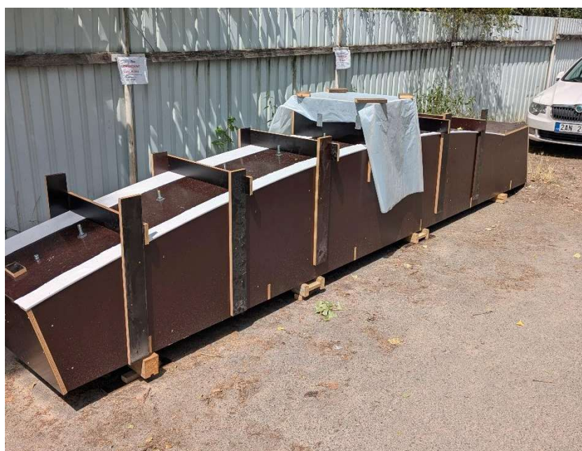
Obr. 29: Odlévání UHPC do bednění; plnění probíhalo po etapách a bylo monitorováno kontrolními a odvodušňovacími otvory.
