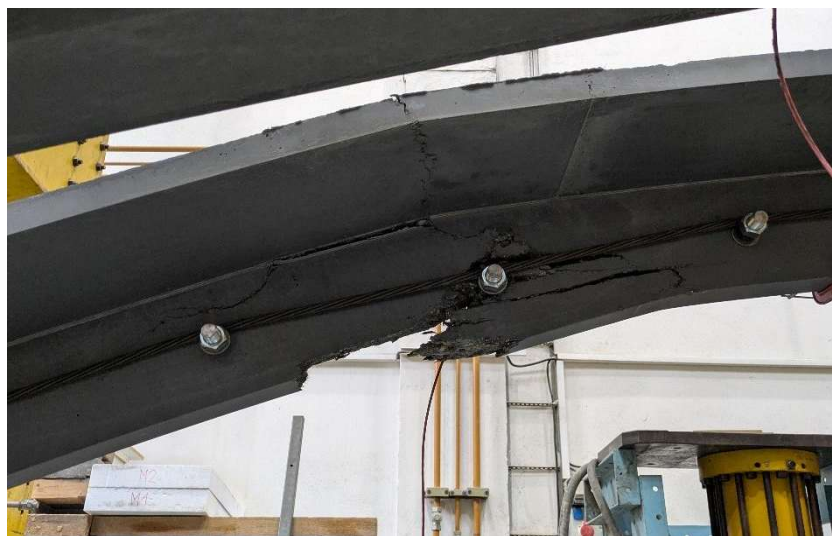
Obr. 40: Porušení tahem, smykem a delaminace tlačené části.
