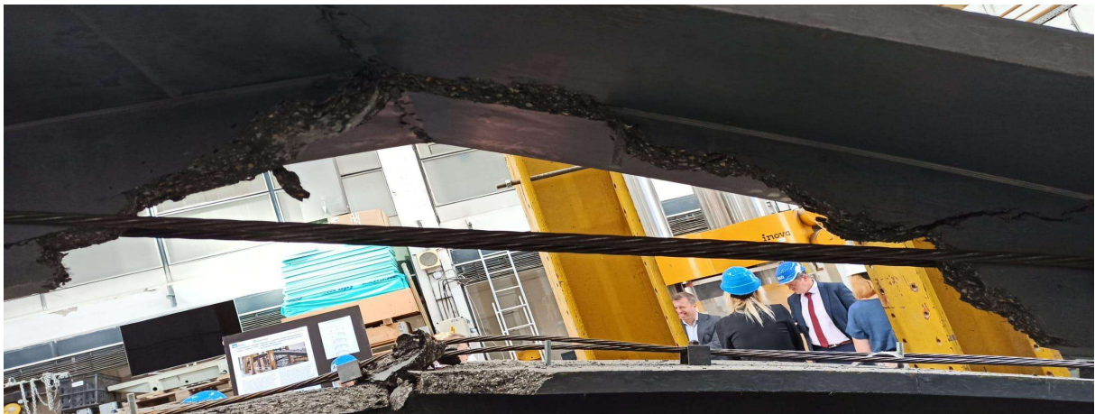
Obr. 39: Porušení ve smyku a oddělení tlačené části.
