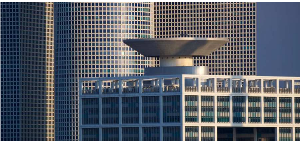
Střešní helipad, Ministerstvo obrany, Matcal Tower, HaKiryat, Tel Aviv, Izrael – příklad originálního architektonického prvku v celkovém výrazu objektu.
