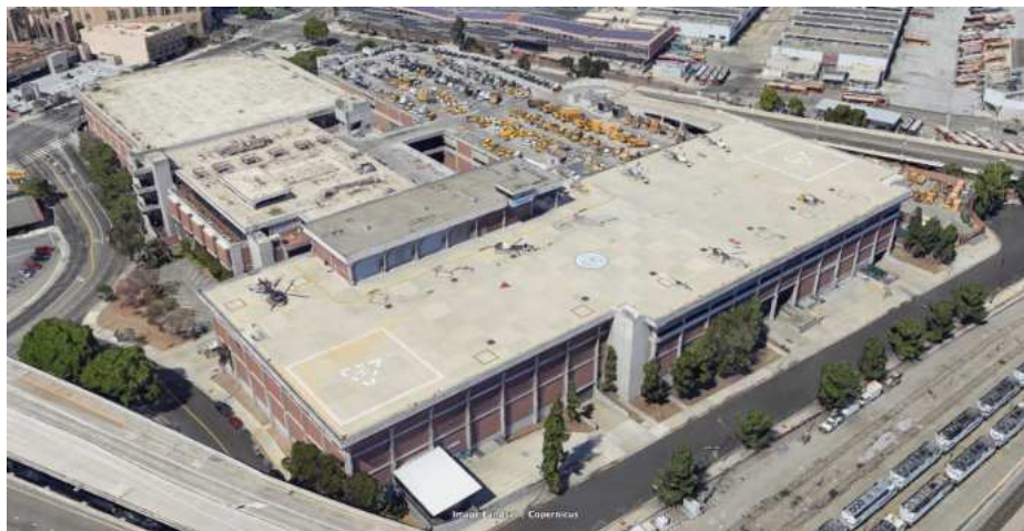
LAPD Hooper Heliport, Los Angeles, Kalifornie – střešní typ
