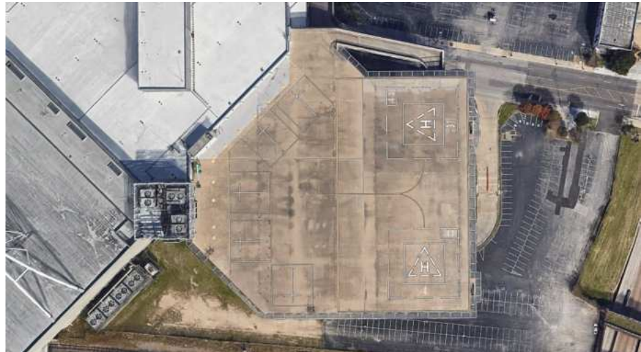
Dallas downtown vertiport umístěný na střeše objektu garáží s topologií satelitních stán, umístěných do vějíře okolo dvou FATO (Zdroj: Google Earth)
