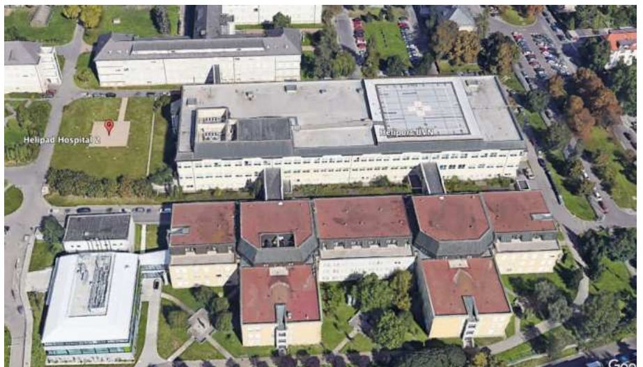
Heliport ÚVN Praha – střešní heliport
