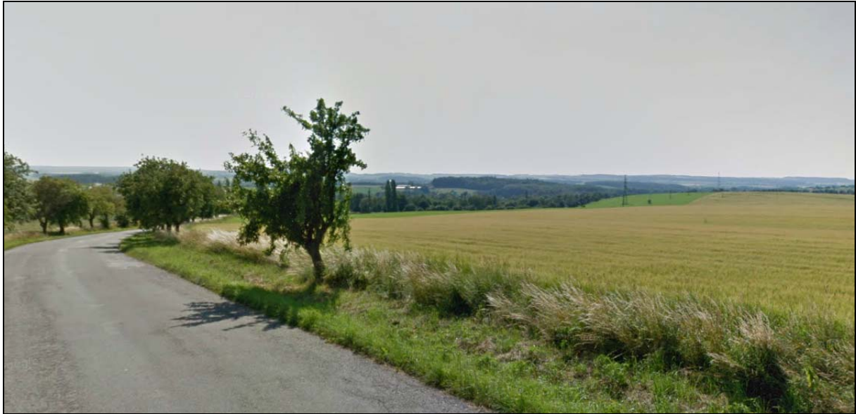
Obr. 27. Pohled od Kornice směrem k plánované MÚK Litomyšl západ
