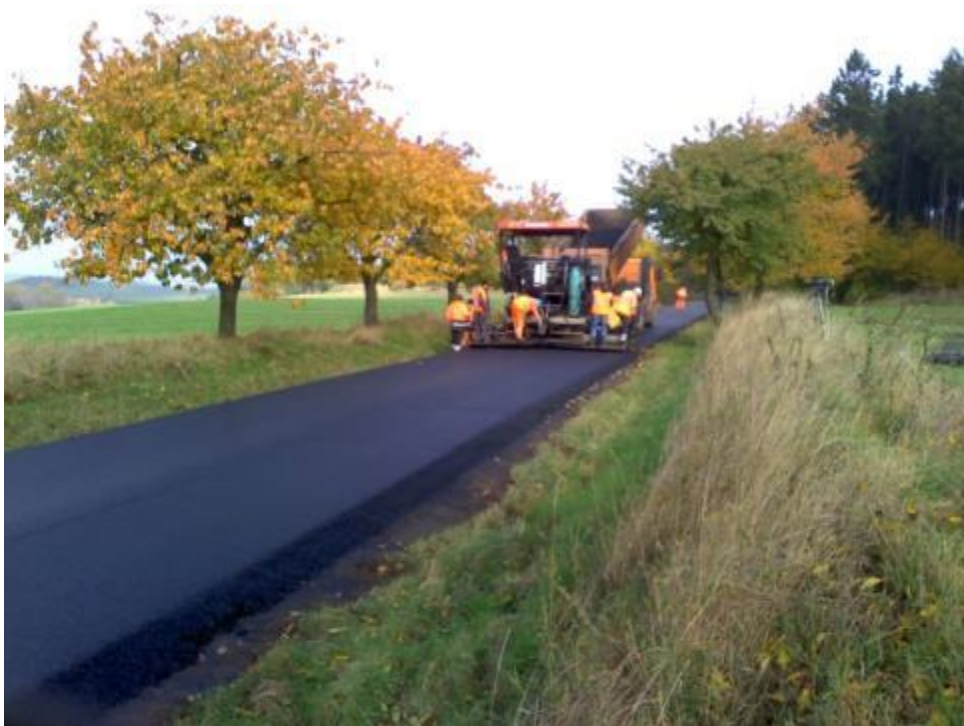
Obr. 1: Průběh pokládky asfaltové vrstvy vozovky finišerem, zdroj: CDV
