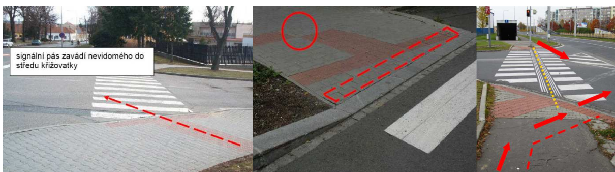
Obr. 15 Příklady špatně provedených přechodů [5]
