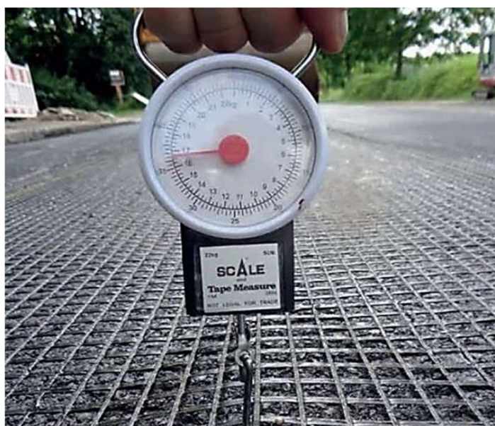
OBRÁZEK 14: Ukázka provádění zkoušky adheze výztužné samolepicí geomříže k povrchu vozovky
