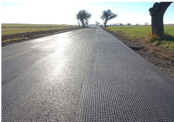
OBRÁZEK 12: Samolepicí výztužná geomříž celoplošně instalovaná na rovný povrch (před aplikací spojovacího postřiku)
