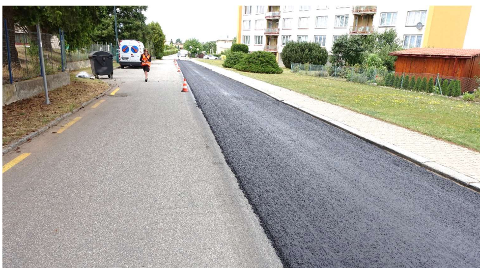
OBRÁZEK 16 Zkušební úsek emulzního mikrokoberce s výztužným geokompozitem (po realizaci)
