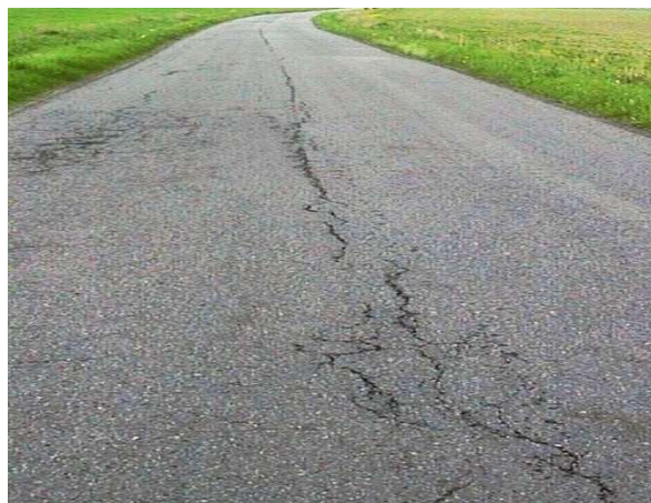
OBRÁZEK 5: Podélná trhlina
