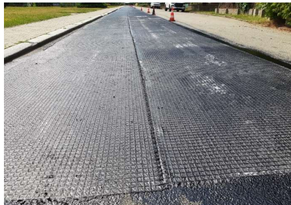
OBRÁZEK 13: Výztužný geokompozit po instalaci do čerstvě naneseného spojovacího postřiku
