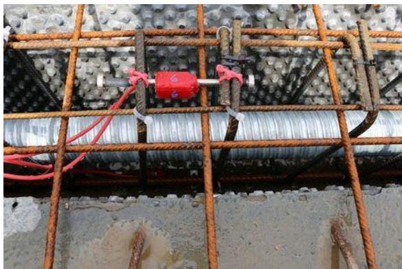
Obr. 3. Osazené strunové tenzometry v nosnících a poloha tenzometrů na příčném řezu.
