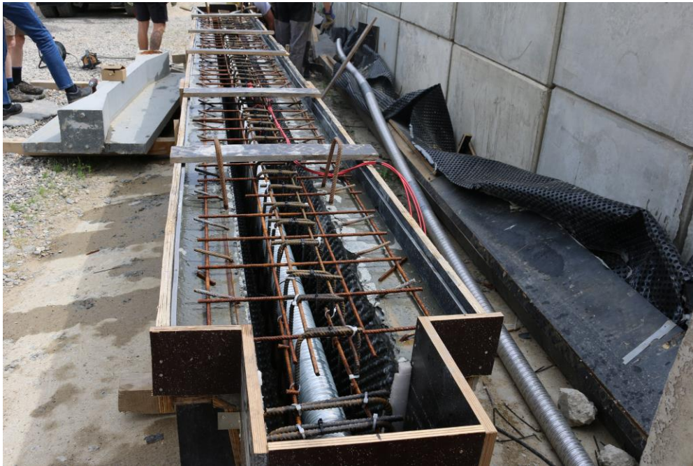
Obr. 1. Příprava betonáže výplně po usazení kanálku pro dodatečné předpětí.
