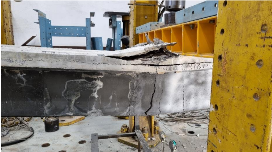
Obr. 9. Porušení nosníku z UHPC č. 133/1.
