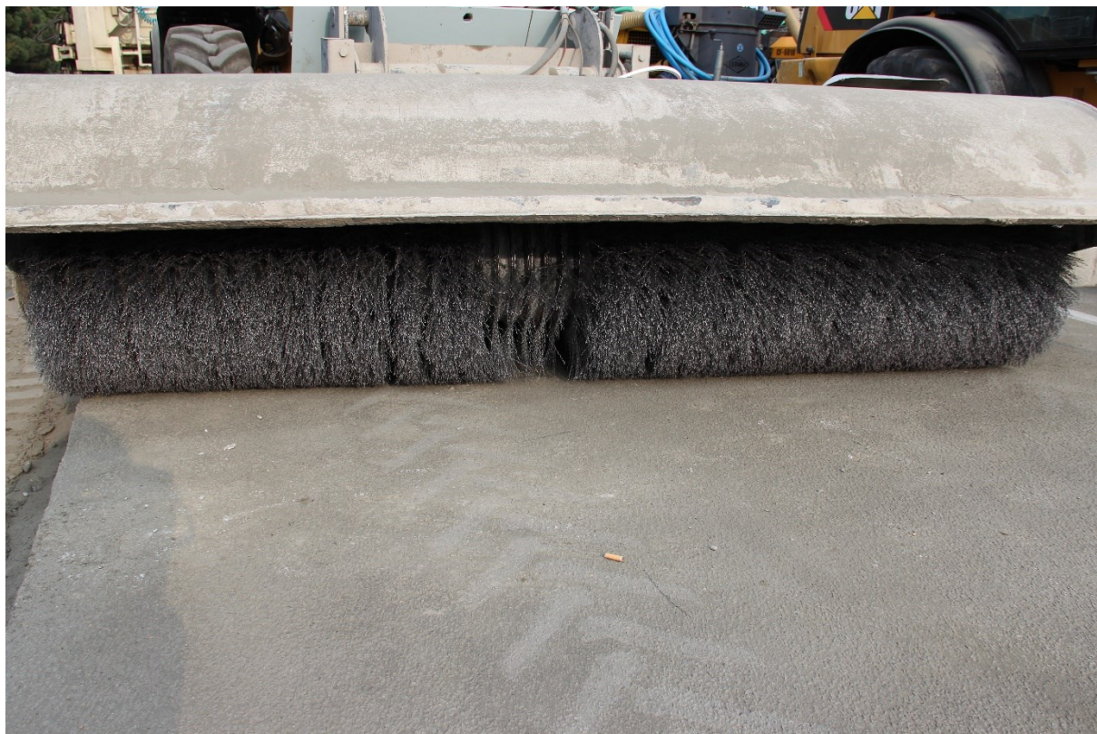
Obrázek 3.5 Kartáč pro vymetání cementové malty z povrchu vozovky
