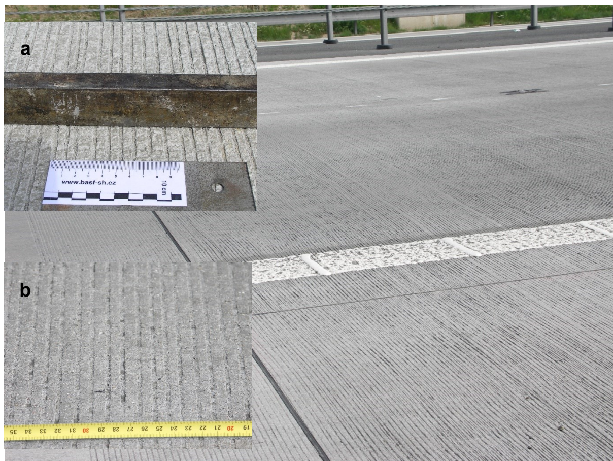
Obrázek 2.6 Příčná textura vytvořená ocelovým hablem (a) ihned po vytvoření (b) po roce provozu
