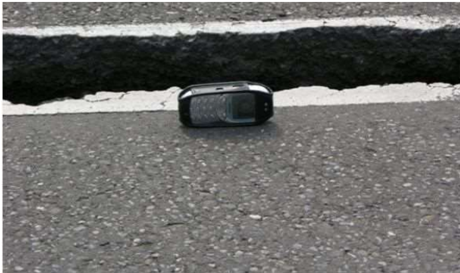
Obr. Č. 11: Deformace vozovky z důsledku důlních vlivů v okolí Katowic
