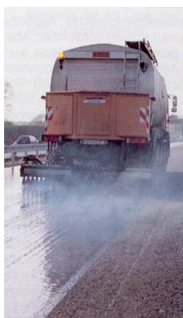
Postřík asfaltovou emulzí
