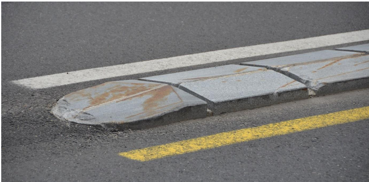
Obr. 49. Slovinsko – Maribor – detail betonové tvarovky fyzického oddělení jízdních pruhů.
