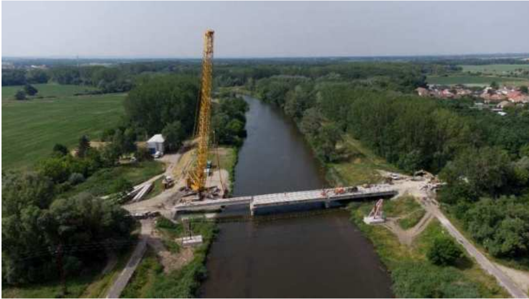
Obr. 11 Pohled na demolici původní konstrukce mostu z prefabrikovaných nosníků I-73
