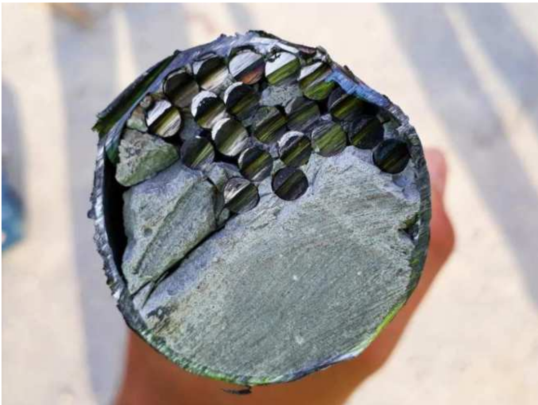
Obr. 137 Plně zainjektovaný kabelový kanálek s předpínací výztuží
