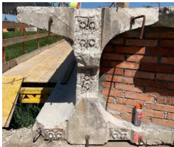
Obr. 8 Pohled na čelo nosníku I-62
