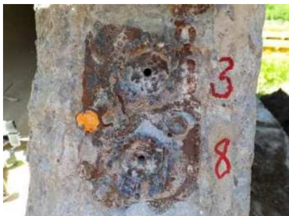
Obr. 127 Sdružená kotva (kuželíky s otvorem)
