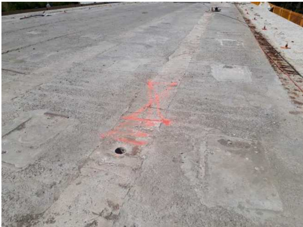
Obr. 44 Označení místa pro otevření diagnostického přístupového otvoru
