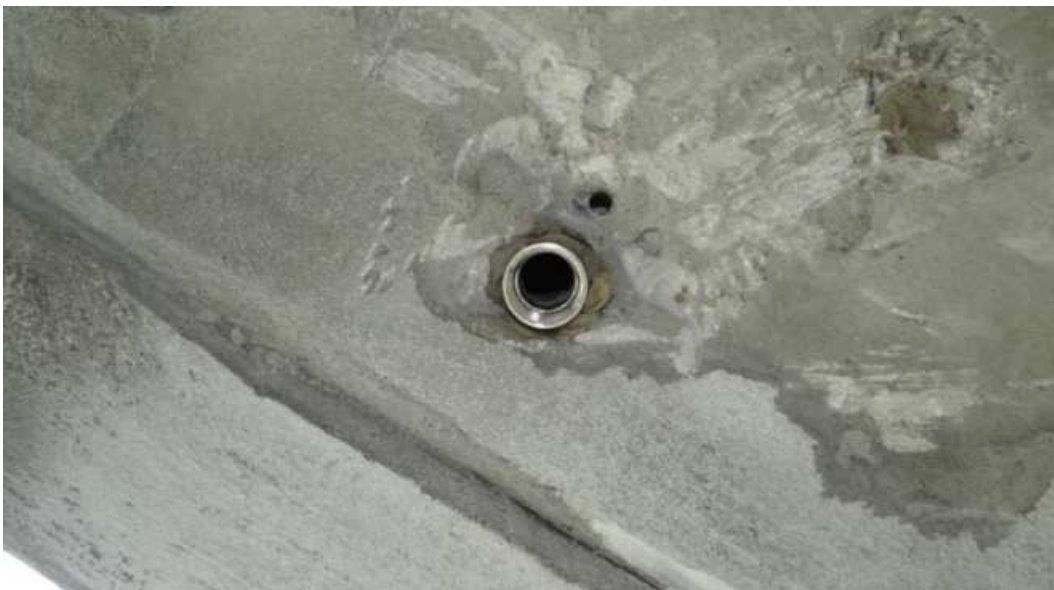
Obr. 164 Ukázka vlepeného pouzdra na lávce pro pěší v Kroměříži
