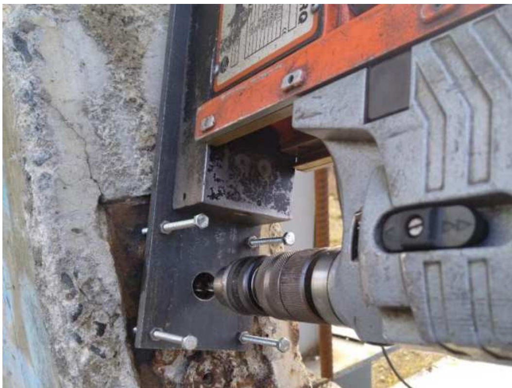
Obr. 136 Detailní pohled na uchycení magnetického vrtacího zařízení a provádění sondážního vrtu
