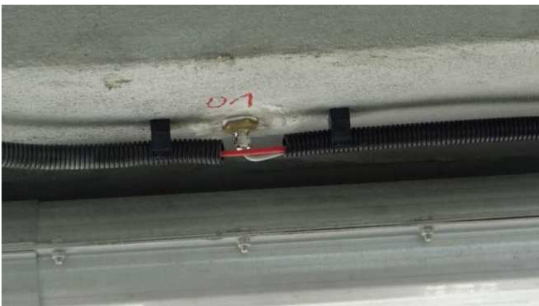
Obr. 167 Pouzdro s osazeným snímačem vlhkosti zapojeným do online monitoringu
