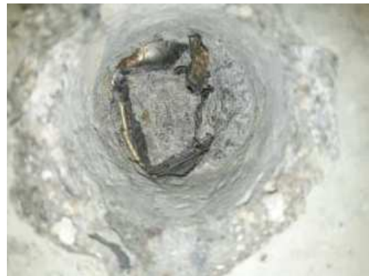
Obr. 55 Kontrola injektáže v SDT sondě
