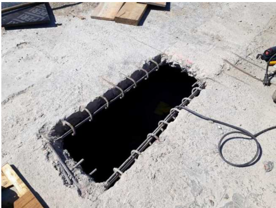
Obr. 46 Hotový diagnostický přístupový otvor ve spáře
