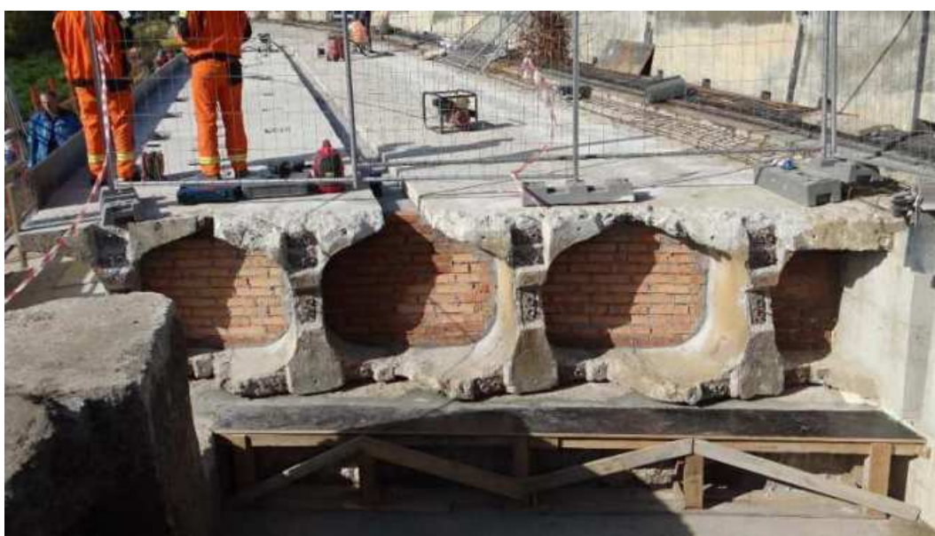
Obr. 106 Odhalené kotevní oblasti předpjatých prefabrikovaných nosníků I-73
