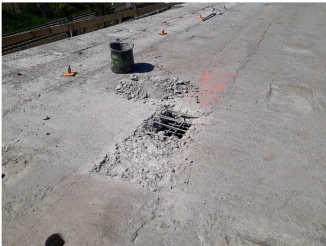
Obr. 45 Postupné vybourávání spáry mezi nosníky
