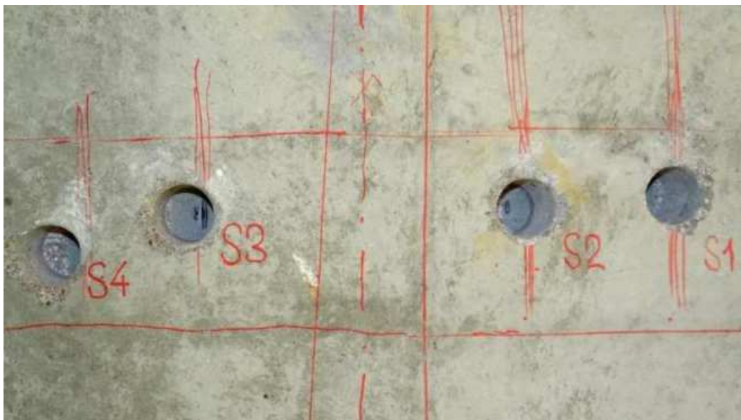
Obr. 16 Pohled na provedené semidestruktivní sondy k předpínací výztuži před zapravením
