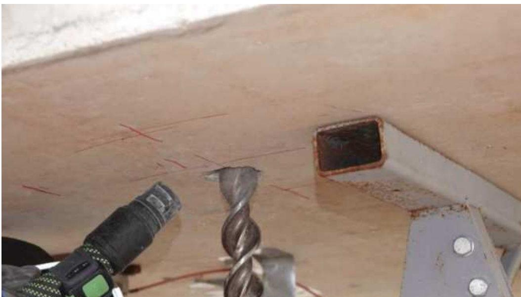
Obr. 160 Rozkreslení polohy senzoru s ohledem na vyztužení, vrtání SDT sondy
