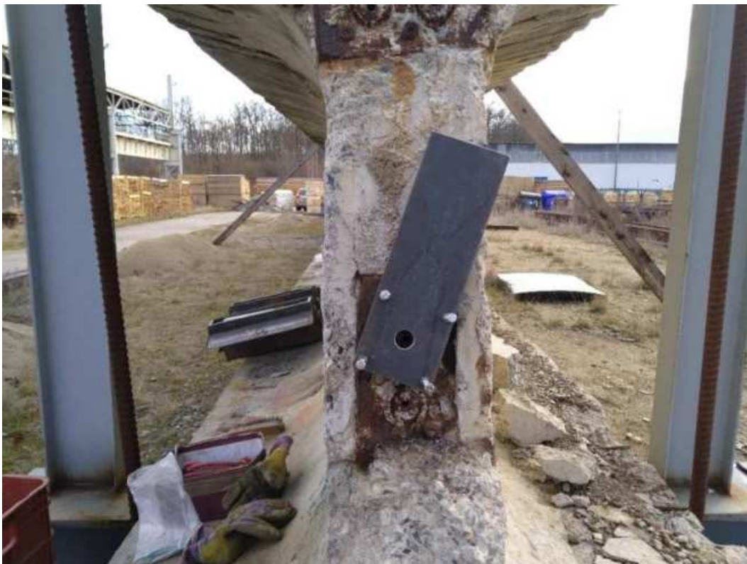
Obr. 133 Čelní pohled na uchycený přípravek pro vrtání
