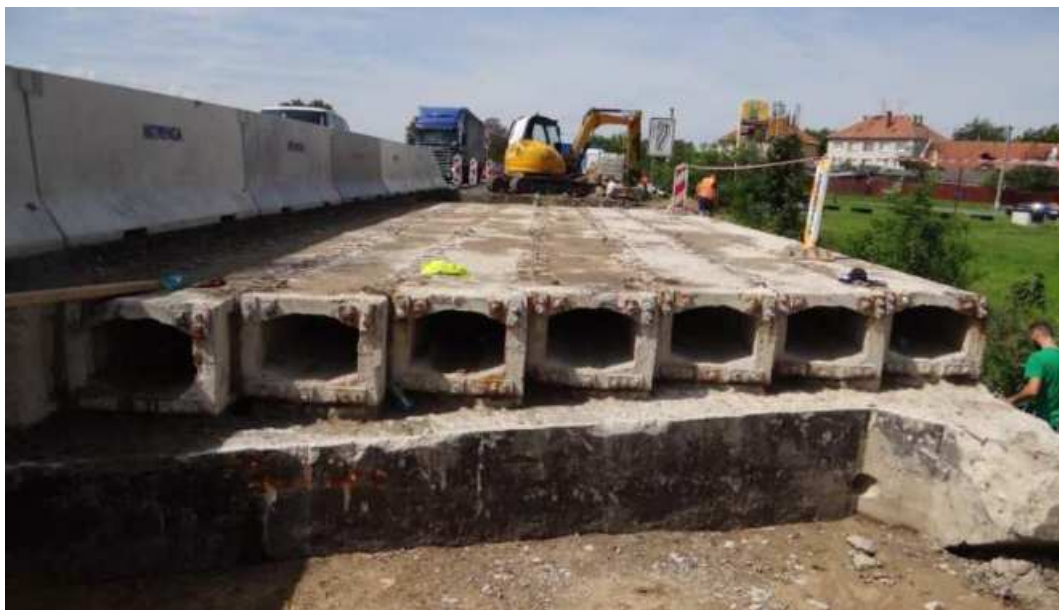
Obr. 10 Uložení nosníků KA-61 dl. 16,6 m na úložném prahu opěry
