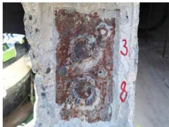
Obr. 128 Sdružená kotva (kuželíky bez otvoru)
