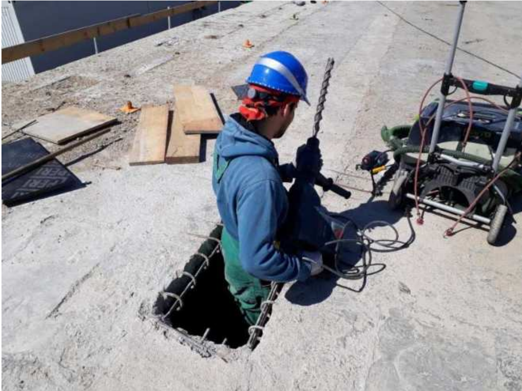
Obr. 47 Pracovník v diagnostickém přístupovém otvoru ve spáře
