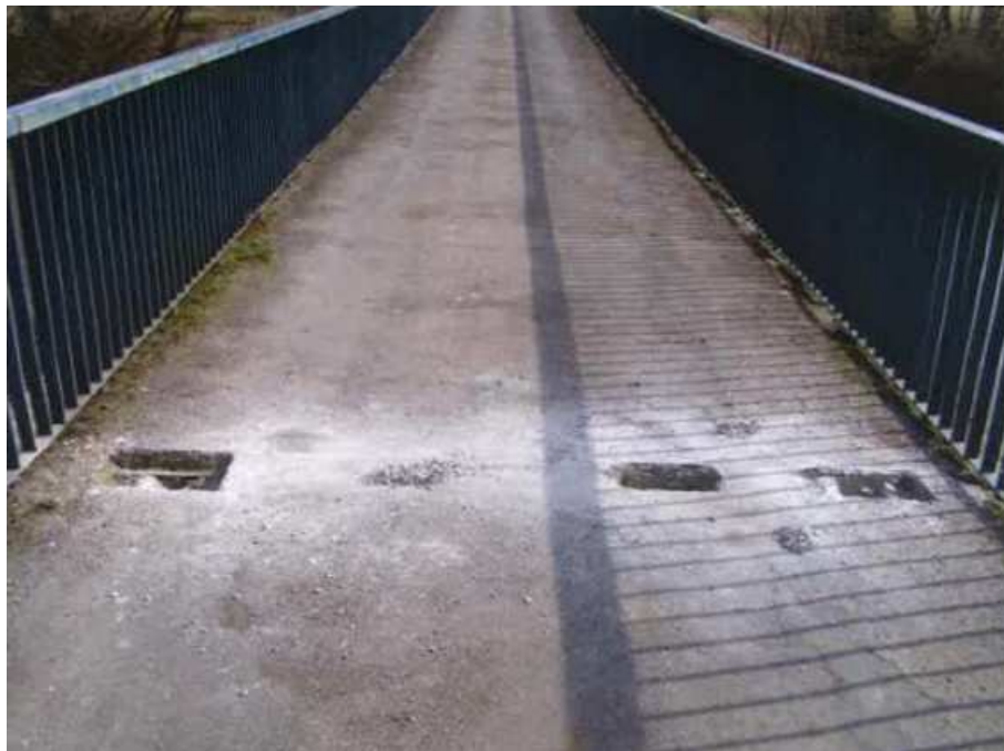
Obr. 13 Celkový pohled na destruktivní sondy k předpínací výztuži [6]
