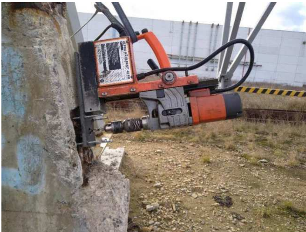
Obr. 135 Boční pohled na uchycení magnetického vrtacího zařízení a provádění sondážního vrtu
