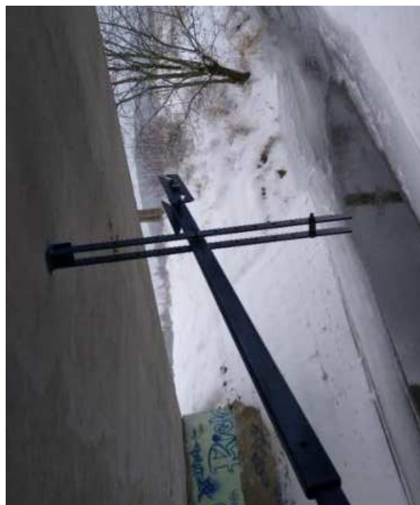
Obr. 123 Detail styku hlavy lafety a stojanu
