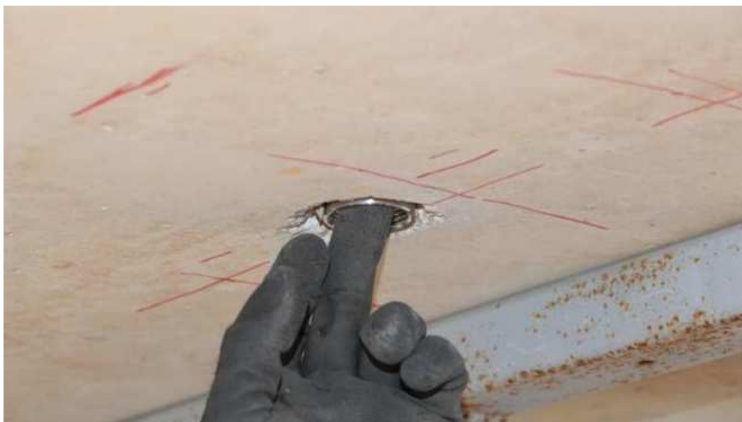
Obr. 162 Vlepení pouzdra senzoru vlhkosti do vrtaného otvoru použitím chemické kotvy
