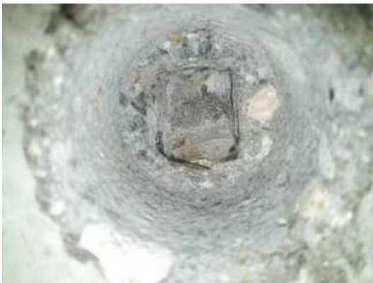
Obr. 54 Kontrola injektáže v SDT sondě
