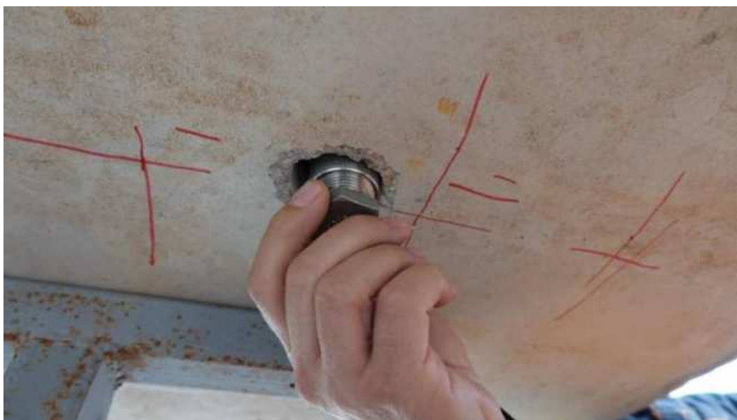
Obr. 163 Možnost uzavření pouzdra před vložením senzoru vlhkosti
