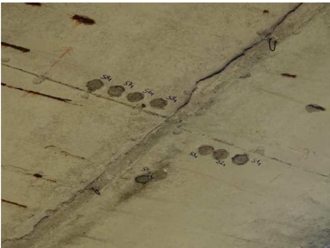
Obr. 70 Ukázka zapravení SDT sond tixotropní maltou
