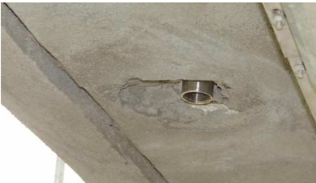
Obr. 165 Ukázka vlepeného pouzdra na lávce pro pěší v Kroměříži
