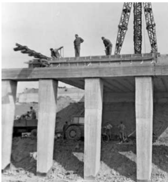
Obr. 15 Použití nosníků KA-61 výšky 0,85 m, most ČS mládeže v Ostravě, tradiční podpěra z několika úzkých pilířů a horního příčnicku, výstavba mostu 60. léta (Demolice a výstavba nového mostu proběhla v roce 2017). Zdroj: www.betontks.cz
