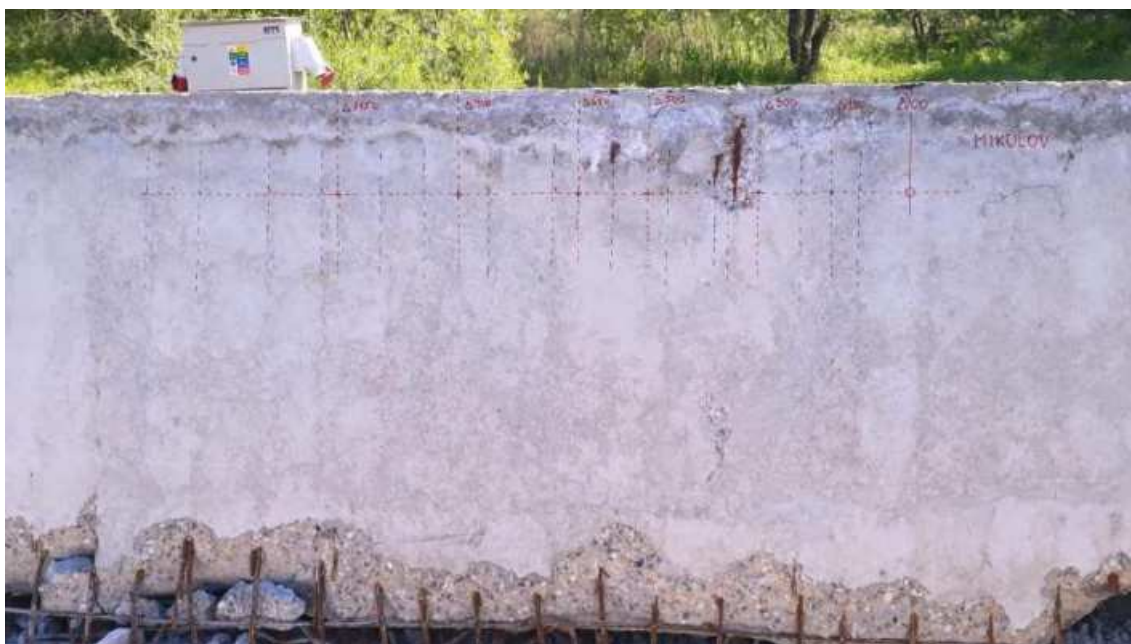
Obr. 4 Označení míst pro otevření SDT sond
