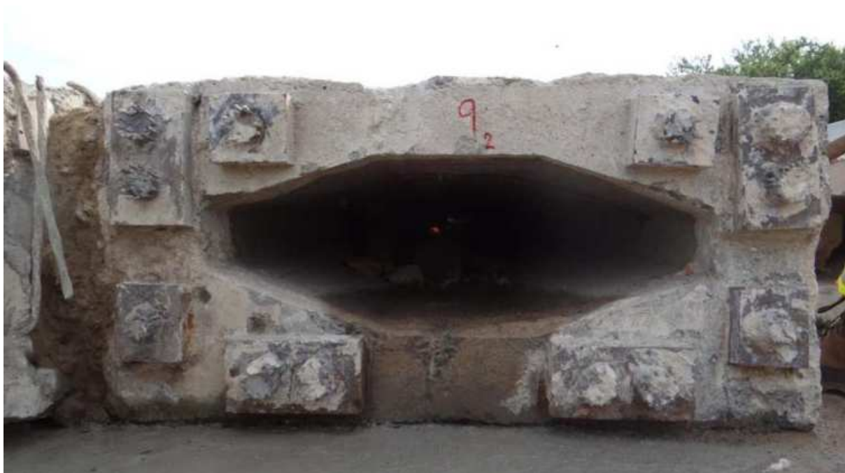
Obr. 16 Čelo nosníku KA-61 dl. 10,6 m
