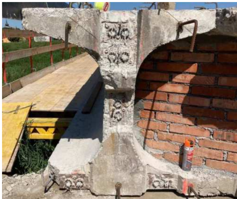
Obr. 2 Čelo nosníku I-62 délky 27,0 m
