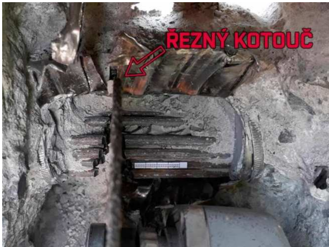
Obr. 50 Pohled do přerušovací sondy s vloženým řezným kotoučem
