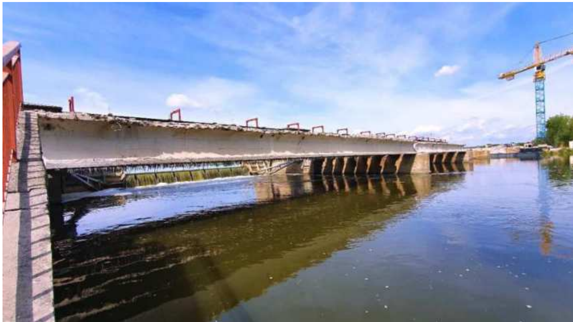
Obr. 12 Most ev. č. 52-059 během demolice
