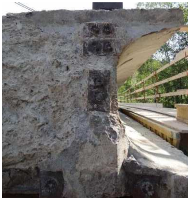
Obr. 7 Pohled na čelo nosníku I-73 dl. 24,0 m
