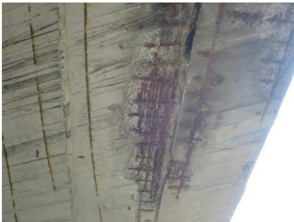
Obr. 50 Odhalené kabelové kanálky u spodního líce prefabrikovaného nosníku.
