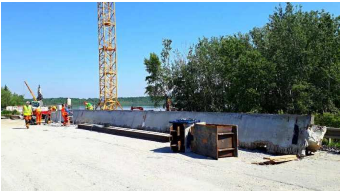
Obr. 14 Pohled na zkoumaný nosník během provádění experimentálních měření kotevní délky
