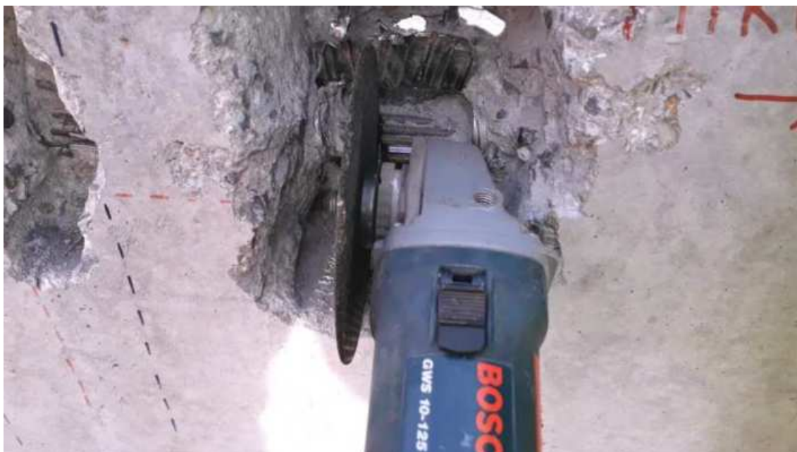
Obr. 8 Pohled na místo přerušení výztuže s přiloženou úhlovou bruskou s kotoučem tloušťky 3,2 mm
