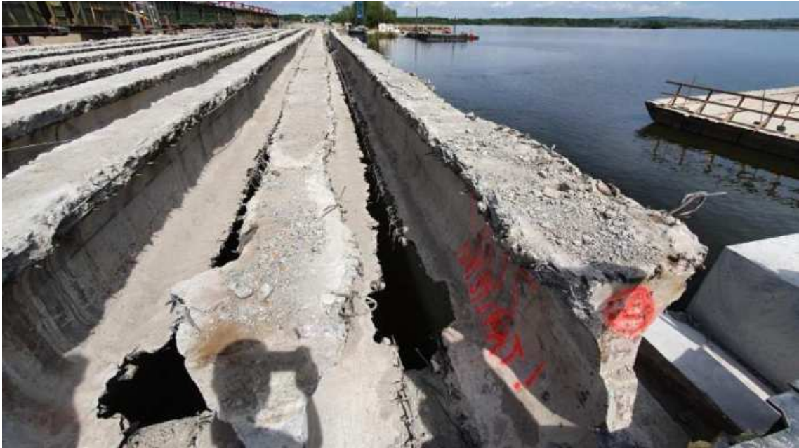
Obr. 13 Vybraný krajní nosník 1 pole mostu ev. č. 52-059
