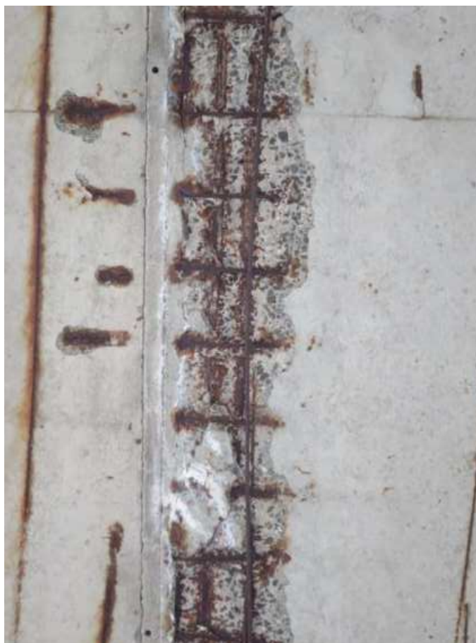
Obr. 49 Separace krycí vrstvy kabelového kanálku a jeho obnažení.
