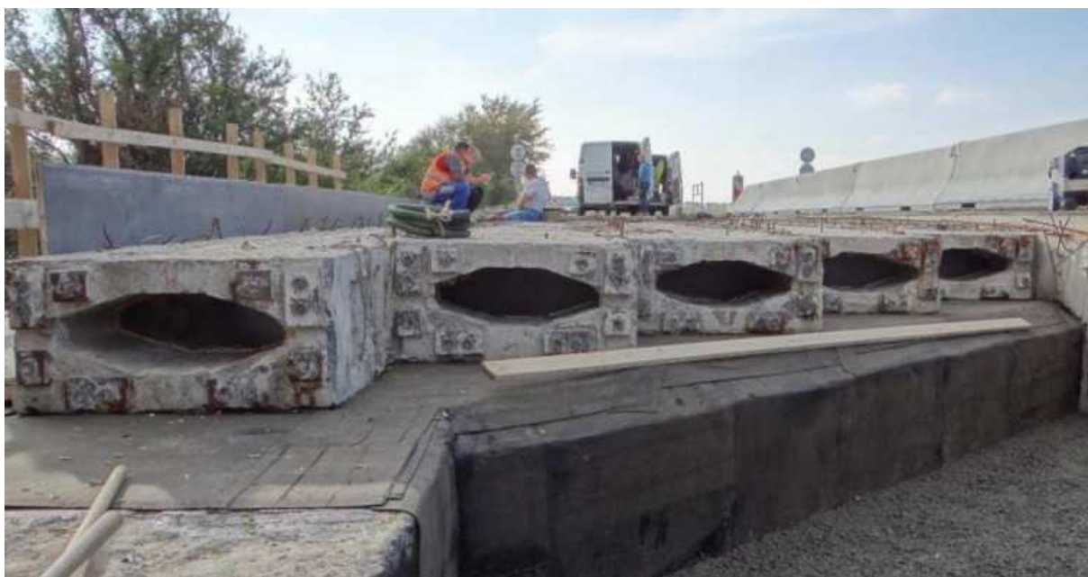
Obr. 17 Uložení nosníků KA-61 dl. 10,6 m na úložném prahu opěry
