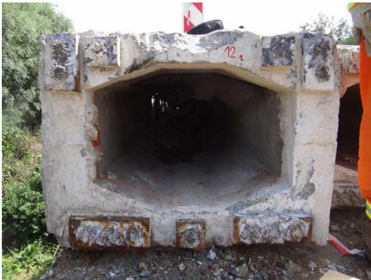
Obr. 18 Čelo nosníku KA-61 dl. 16,6 m
