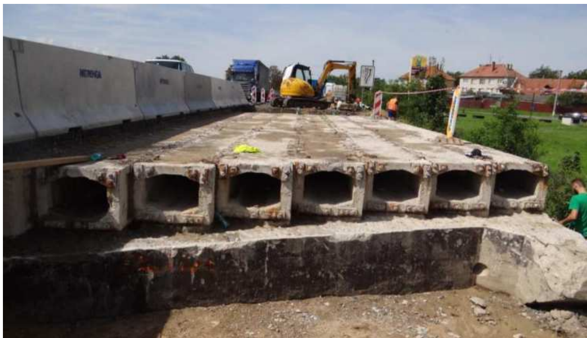
Obr. 19 Uložení nosníků KA-61 dl. 16,6 m na úložném prahu opěry
