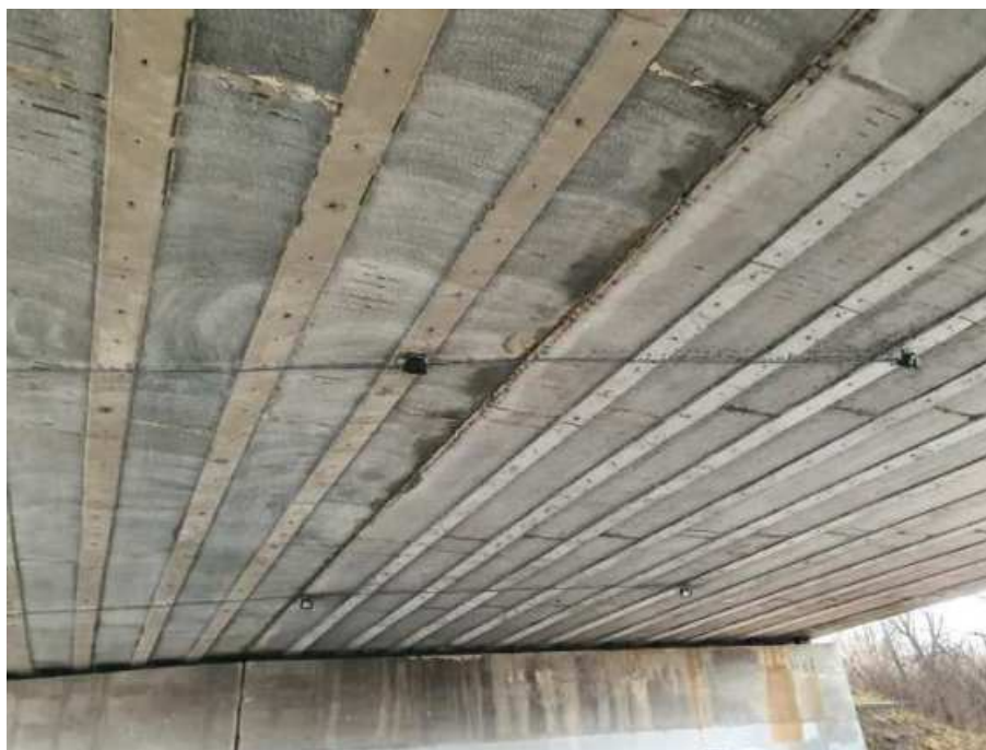
Obr. 11 Pohled na spodní líc nosníků IS-73
