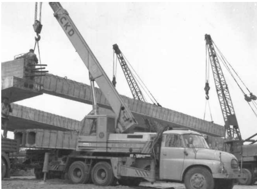
Obr. 13 Použití nosníků KA-61 dl. 21,0 m, most na silnici II/272 v Lysé nad Labem, výstavba mostu 1968-1973 (Demolice a výstavba nového mostu proběhla v roce 2018). Zdroj: https://silnice-zeleznice.cz/silnicni-infrastruktura/ii-272-lysa-nad-labem-rekonstrukce-mostu-ev-c-272-006-102
