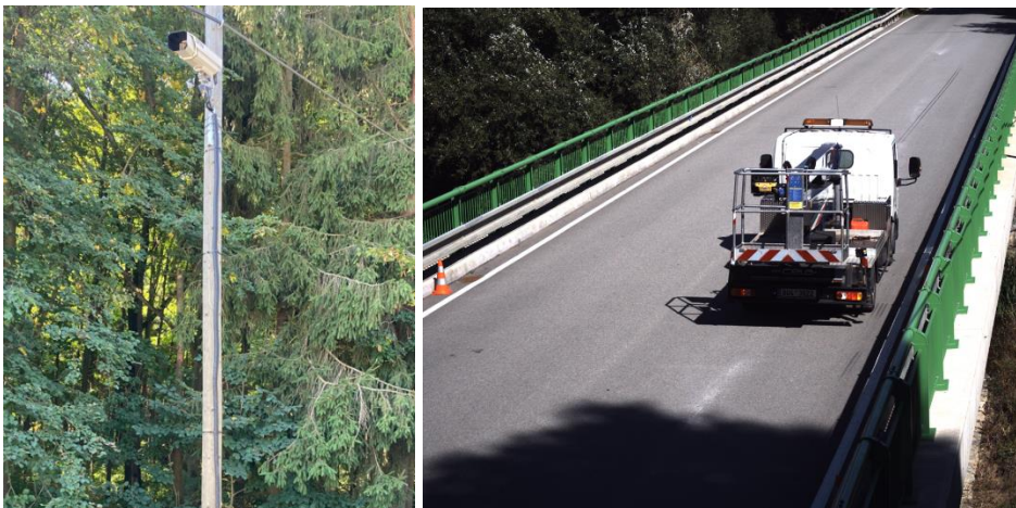
Obrázek 1: Kamera a její pohled na těleso mostu s projíždějícím testovacím vozidlem
