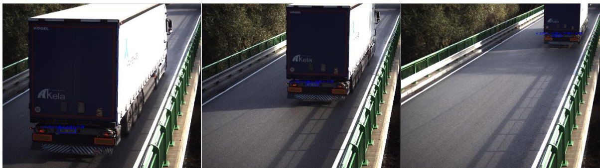
Obr. 9Příklad instalace kamery a záběru vozidla na mostní konstrukci
