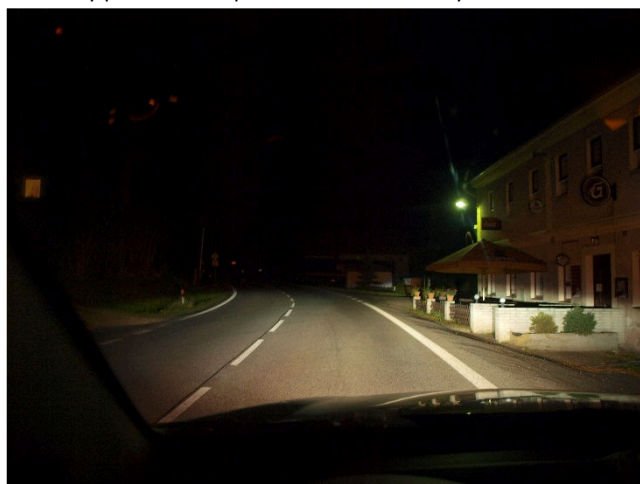
Obr.3 špatně osvětlený prostor průjezdné komunikace I. tř. za dosahem reflektorů vozidla je neviditelný oblouk vozovky
