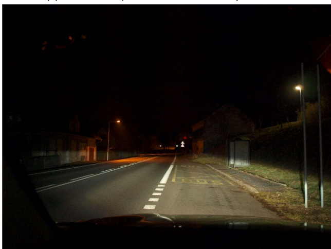
Obr. 2 špatně osvětlený prostor průjezdné komunikace I. tř. nerovnoměrně osvětlená komunikace
