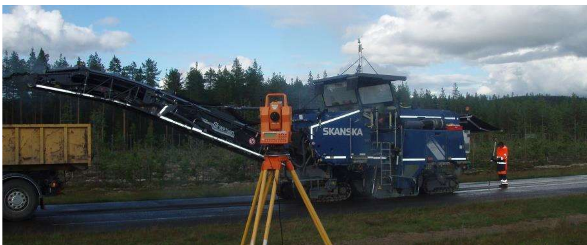
Obrázek 20: Frézovací práce dálkově řízené totální stanicí. Terč je umístěný v dostatečné výšce nad strojem a propojený s řídicím počítačem. [3, s. 8]
