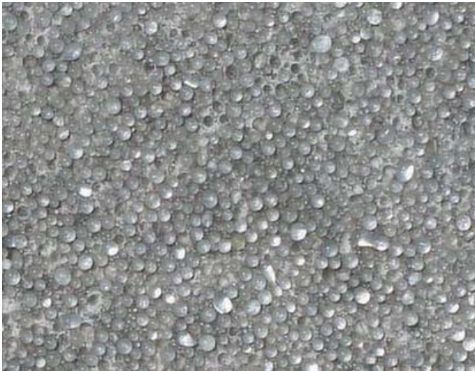
Obrázek 7 – Příklad nedostatečného zabudování materiálu na dodatečný posyp
