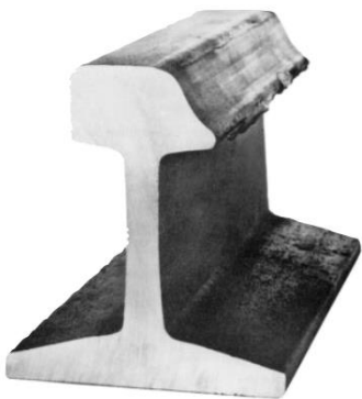
Obr.2 Příklad opotřebeného profilu kolejnice [1]
