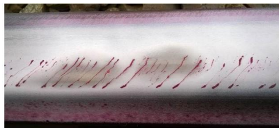
Obr.3 Příklad kontaktně-únavového poškození hlavy kolejnice (head check) [1]
