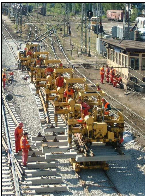
Obr. 3.14 UWG- kladení výhybky
