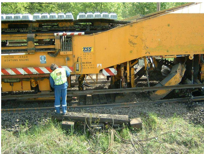
Obr. 3.8 SUM 1000 CS- těžící zařízení s dopravníkem nových pražců
