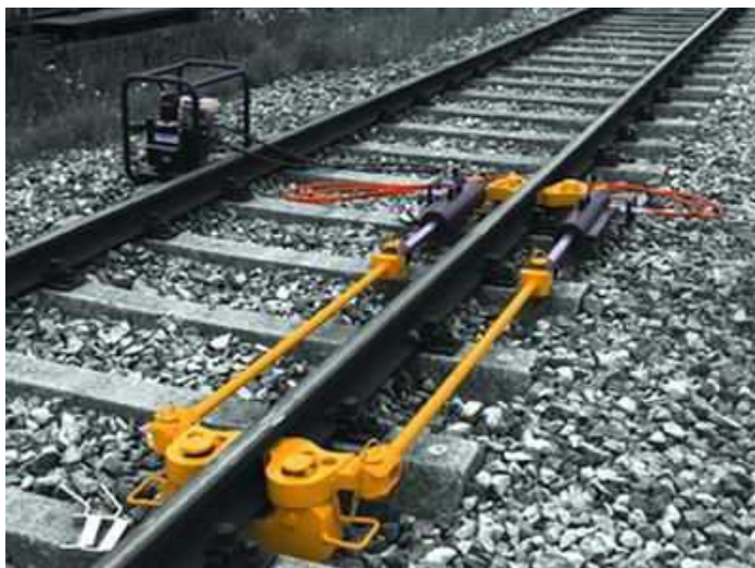
Obr. 3.11 Napínací zařízení Robel 24.70
