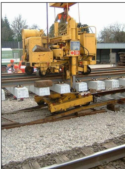
Obr. 3.16 UWG- nájezd na pomocnou drážku
