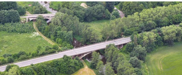
↑ Historický a současný most přes Skalci
