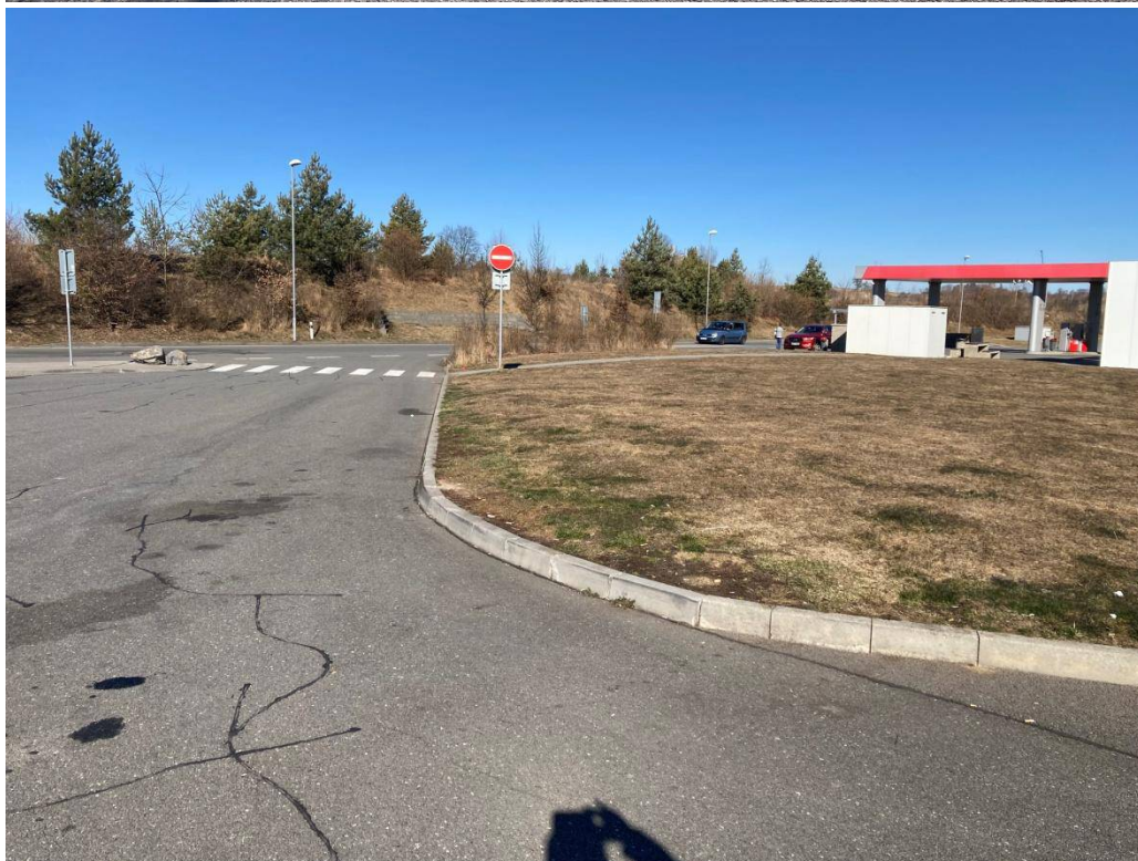
foto místa stavby
