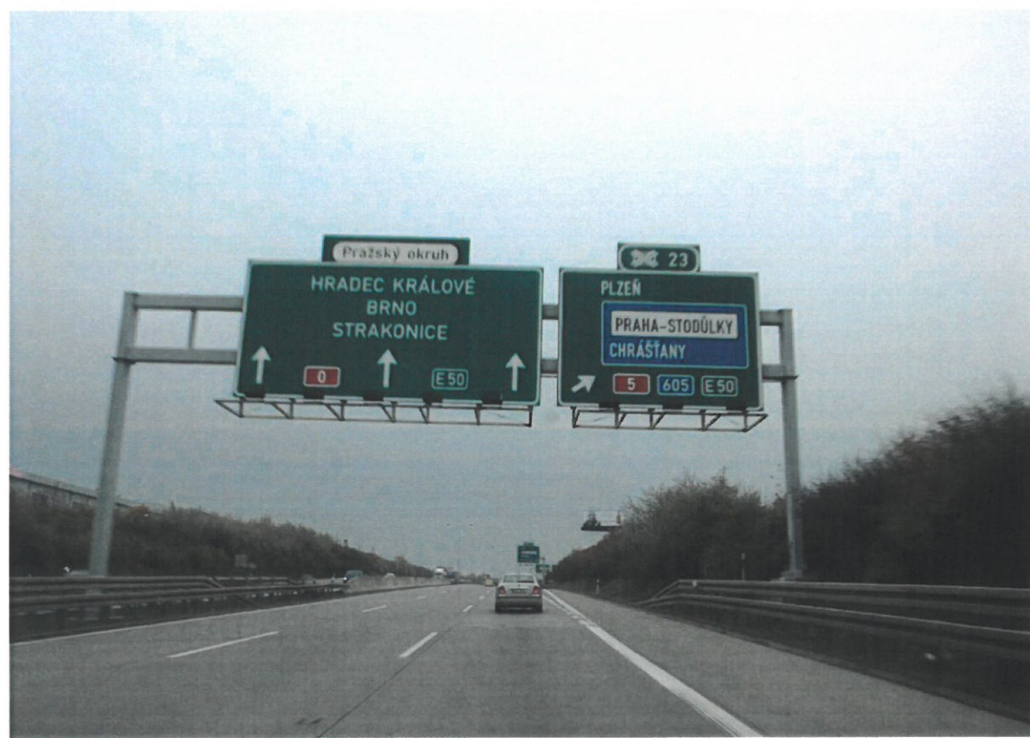
Dálnice D0 - uzavírka křižovatky 23A, portál "l" - bez úprav
