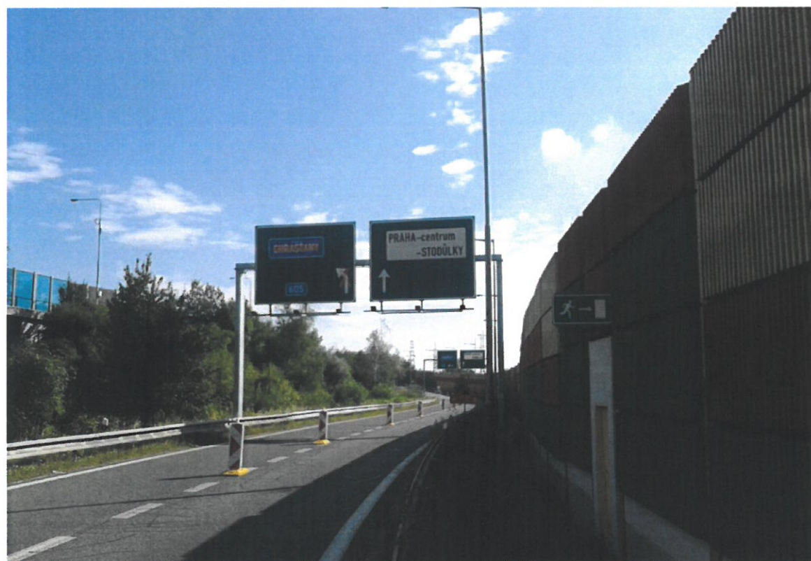
Dálnice D0 - uzavírka křižovatky 23A, portál "f" - stávající stav
