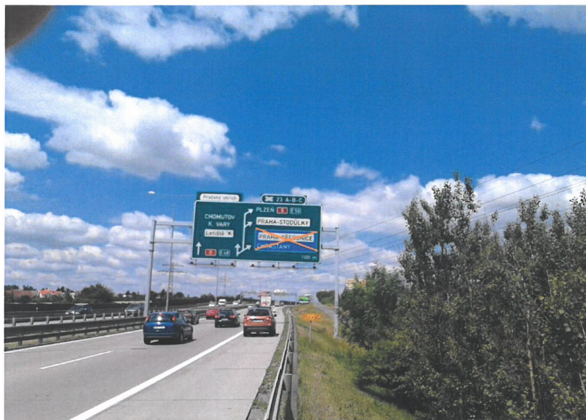
Dálnice D0 - uzavírka křižovatky 23A, portál "a"
