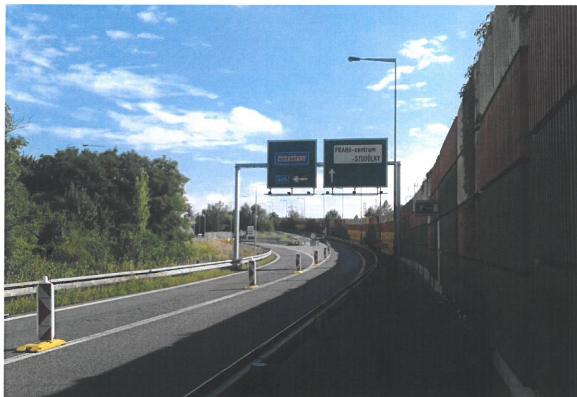
Dálnice D0 - uzavírka křižovatky 23A, portál "g" - stávající stav
