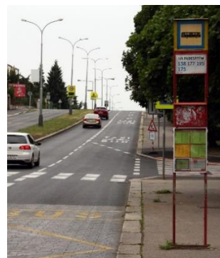
A57 // Návaznost zastávkového pruhu na vyhrazený jízdní pruh (ul. Na Padesátem, Praha).
