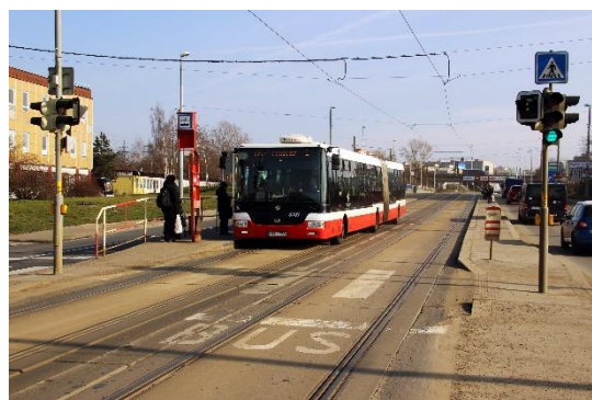
B63 // Přechod pro chodce řízený SSZ přes tramvajový pás s provozem autobusů VHD.
