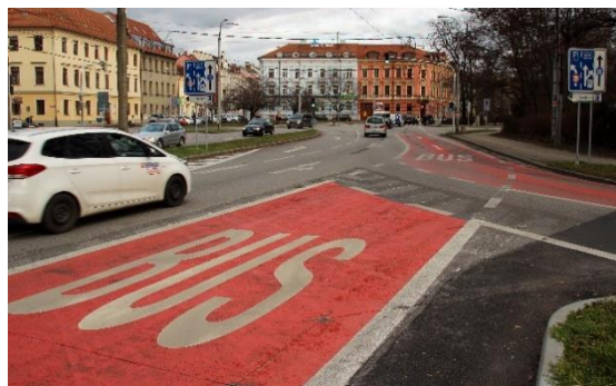
A68 // Zvýraznění vyhrazeného jízdního pruhu pro autobusy.
