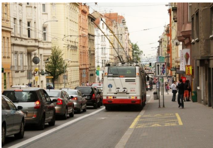
A09 // Vyhrazený jízdní pruh pro autobusy a trolejbusy o šířce 2,75 m (ul. Úvoz, Brno)
