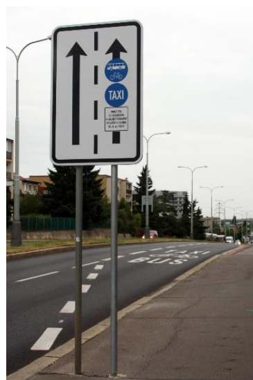
A12 // Svislé a vodorovné dopravní značení vyhrazeného jízdního pruhu (ul. Na Padesátém, Praha).
