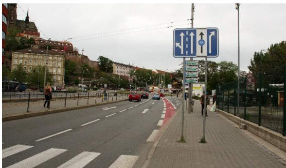
A67 // Zvýraznění vyhrazeného jízdního pruhu pro jízdní kola.
