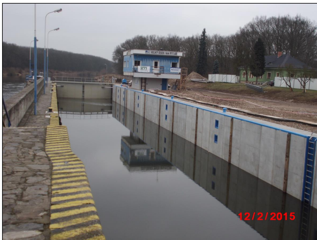
Obrázek. 3.10 Stav po dokončení 1. etapy rekonstrukce PK Velký Osek, Zdroj: [48]
