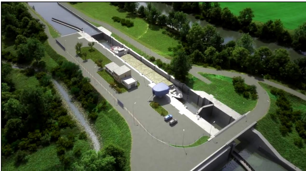
Obrázek. 3.21 Vizualizace plavební komory navrhované v rámci plavebního stupně Přelouč II, Zdroj: [48]
