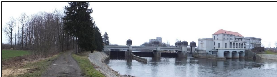
Obrázek. 3.18 Stávající jez, plavební komora a MVE v Přebouči – pohled proti vodě, Zdroj: Vlastní zpracování
