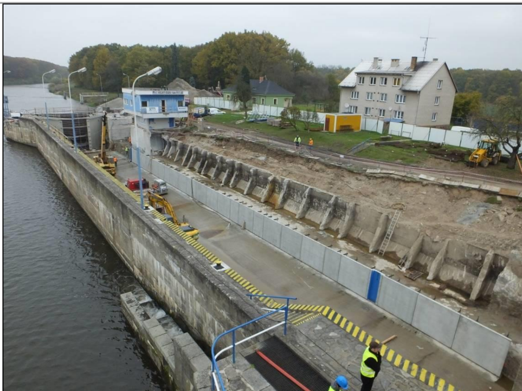
Obrázek. 3.9 1. etapa rekonstrukce PK Velký Osek (listopad 2014) - stav s vybouranou pravou zdí komory, probíhající montáží první řady prefabrikátů a opravou dolních vzpěrných vrat, Zdroj: Vlastní zpracování
