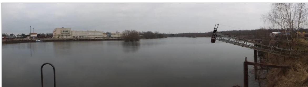
Obrázek. 3.12 Aktuální stav přístavu Chvaletice - pohled proti vodě, Zdroj: Vlastní zpracování
