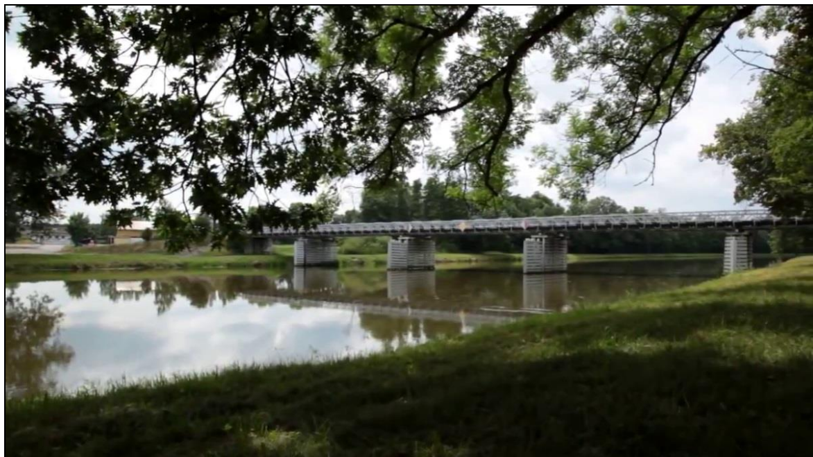
Obrázek. 3.23 Současný stav silničního mostu Valy – Melice – mostní provizorium, Zdroj: [48]
